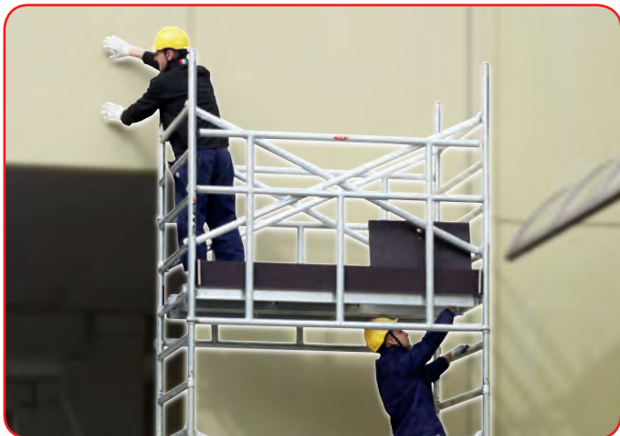
TEMPO SAFE L montato all'altezza di m 5,50 Altezza massima piattaforma/lavoro: m 4,50/6,50 Ingombro della struttura: cm 135x200
