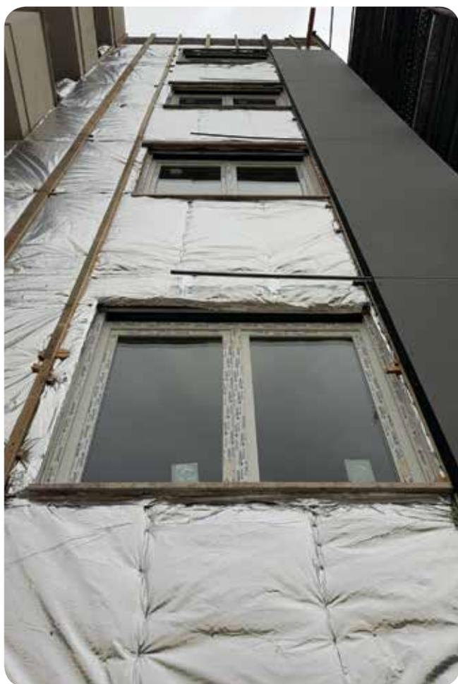
**Over-foil Multistrato 19** è un **isolante termo-riflettente in alluminio**, ideale per contenere gli spessori sia nelle ristrutturazioni che nelle nuove costruzioni in abbinamento a sistemi a secco. Utilizzato nei **cappotti termici** e nei **controsoffitti**, permette di sfruttare gli spazi d'aria che si creano, ottenendo così strutture altamente performanti ma a **bassissimo spessore**.
