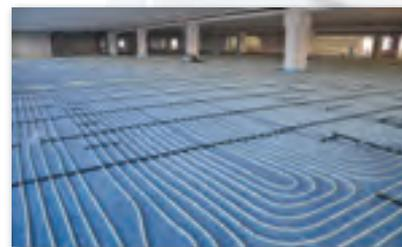
nato ad un riscaldamento a pavimento. Il tempo necessario per riscaldare il pavimento si riduce approssimativamente del 25% e la temperatura superficiale del pavimento aumenta in media di 2/3 gradi centigradi.
