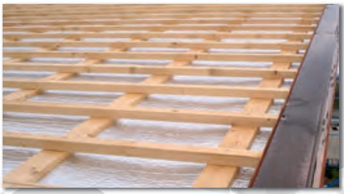
**Over-foil 2L-2** è un materiale isolante termoriflettente che possiede caratteristiche di isolamento termoacustico di assoluto rilievo e permette di realizzare, con un unico prodotto, strutture in grado di soddisfare le normative vigenti sia in merito all'isolamento termico che all'isolamento acustico.
