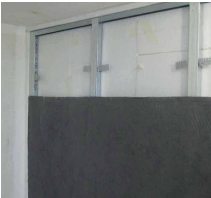
Isolante Over-foil Clima fissato sulla struttura metallica con nastro biadesivo e con lato in TNT verso l'interno.
