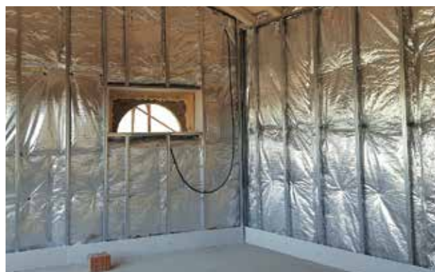
Isolante Over-foil Multistrato 19 fissato ai listelli in legno
