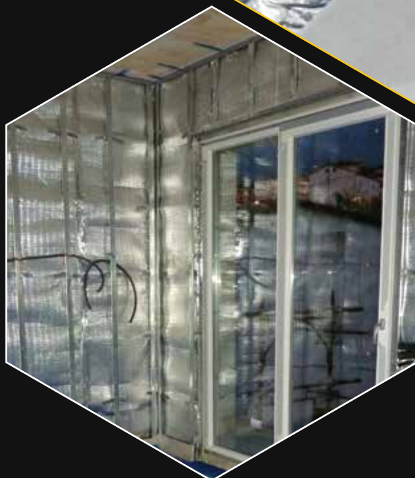
L'impianto elettrico si snoda nell'intercapedine tra l'isolante e la finitura interna (cartongesso) garantendo così la continuità dell'isolante.
