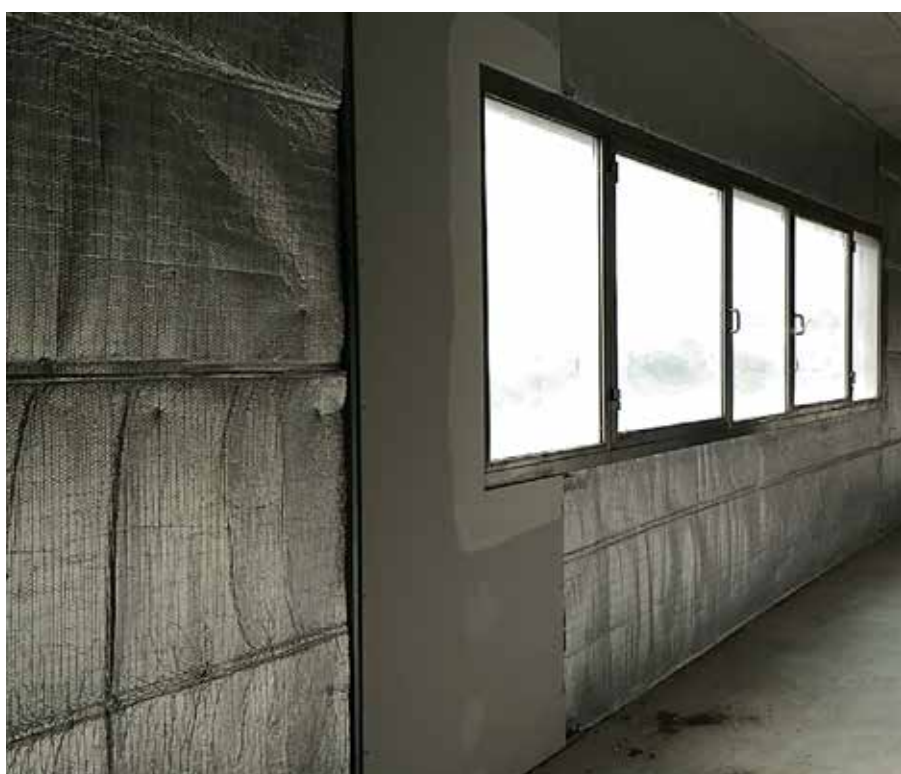
Isolante Over-foil 311 fissato ai listelli in legno
