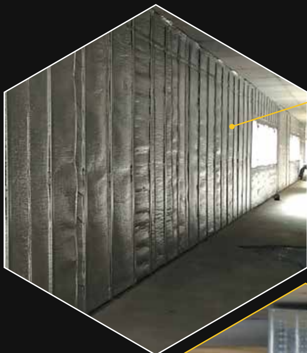
Isolante Over-foil 311 aggraffato ai listelli di legno
