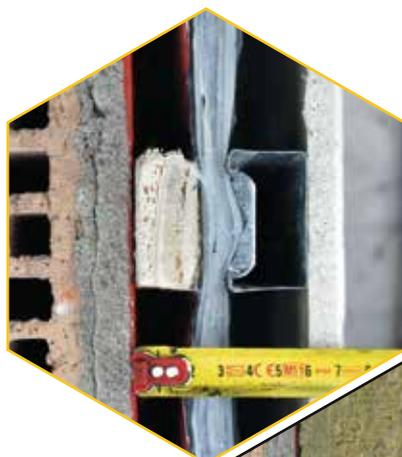
A lato una parete isolata con **Over-foil Multistrato 19** e sotto la stessa parete isolata con altro materiale dello spessore necessario per ottenere la medesima prestazione termica.
