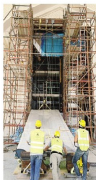
Operai montano il portone
