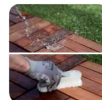
Trascorsa circa mezz'ora, pulire con abbondante acqua togliendo ogni residuo di prodotto con l'ausilio di una spazzola con setole dure.
