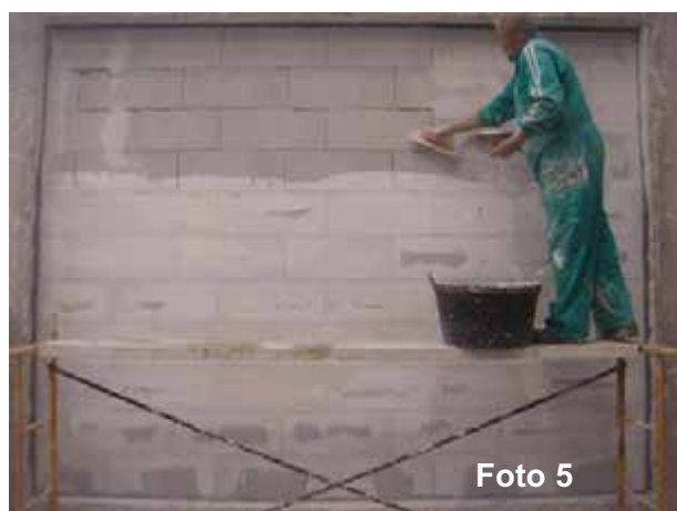
Fotos 5 y 6: Aplicación de revestimiento
