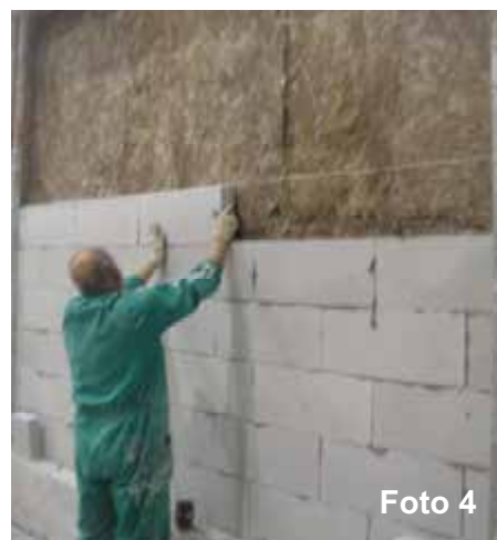
Fotos 3 y 4: Montaje de lana mineral y fábrica
