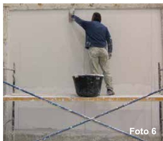
Fotos 5 y 6: Aplicación de revestimiento
