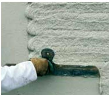
L'intonaco esterno gioca un ruolo essenziale sia per l'estetica che per la protezione dalle intemperie come precipitazioni, vento e variazioni importanti della temperatura. L'intonaco esterno viene normalmente applicato in due strati, un intonaco di fondo, ed un intonaco di copertura o finitura.
