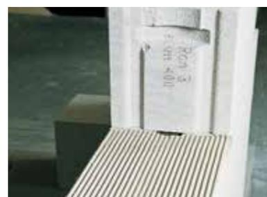
Regolare i blocchi, in larghezza e in altezza, con la sega a nastro, dopo aver verificato l'esatta misura necessaria per completare il corso.
