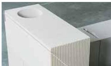
**7** Nell'angolo incollare il lato verticale liscio prima della posa del secondo blocco.
