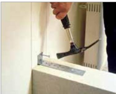
Ogni 3 file, ancorare il blocco alla parete o struttura esistente, come indicato per i blocchi da tamponamento.
