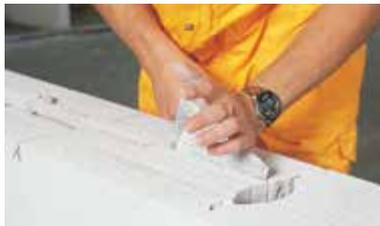
Posare un letto di malta a forte dosaggio sul fondo della gola e posarvi un tondino di acciaio ad aderenza migliorata, **diametro 8 o 10 mm**.
