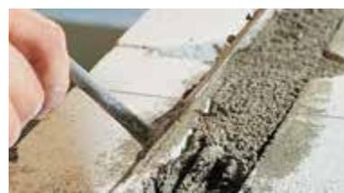
In questi casi è necessario predisporre nell'intonaco di rivestimento una rete di armatura per evitare fessure e cavillature dovute alla disomogeneità della parete.
