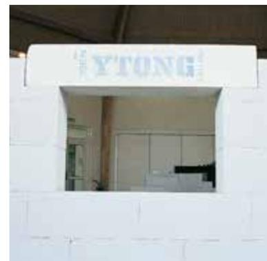
Per ridurre il ponte termico dovuto all'architrave in c.a., inserire sul lato esterno delle conchiglie/blocchi ad U un pannello isolante di spessore sufficiente.
