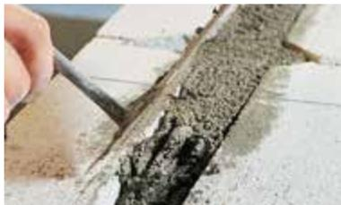
**Per spessori delle pareti superiori a 30 cm, si consiglia la posa di 2 o più ferri di armatura o tralicci sottili, al fine di garantire il rinforzo in maniera diffusa.**
