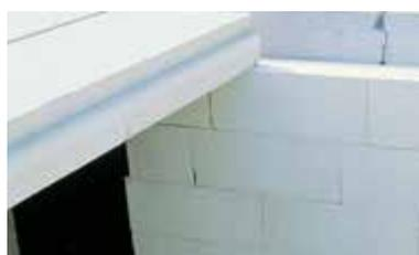
In caso di posa su una muratura che non sia Ytong, procedere a un livellamento idrofugo.
