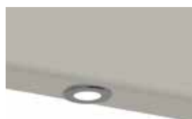
Sistema di illuminazione a LED integrato nelle travi.
