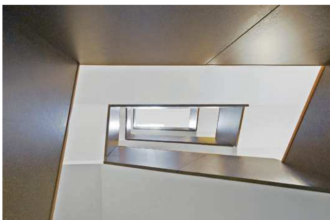
Casa multifamiliare, Wallisellen ZH/Svizzera Architettura: Voelki Nüesch, Zurigo
