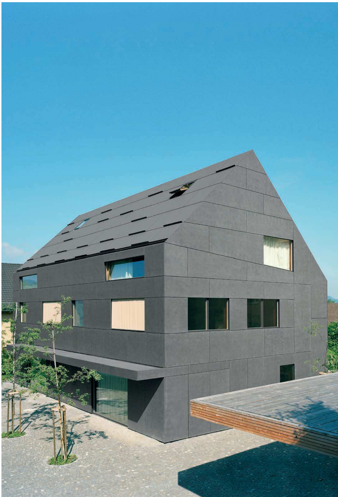
Casa multifamiliare, Küsnacht/Svizzera, Architettura: Rossetti + Wyss Architekten AG, 8037 Zurigo
