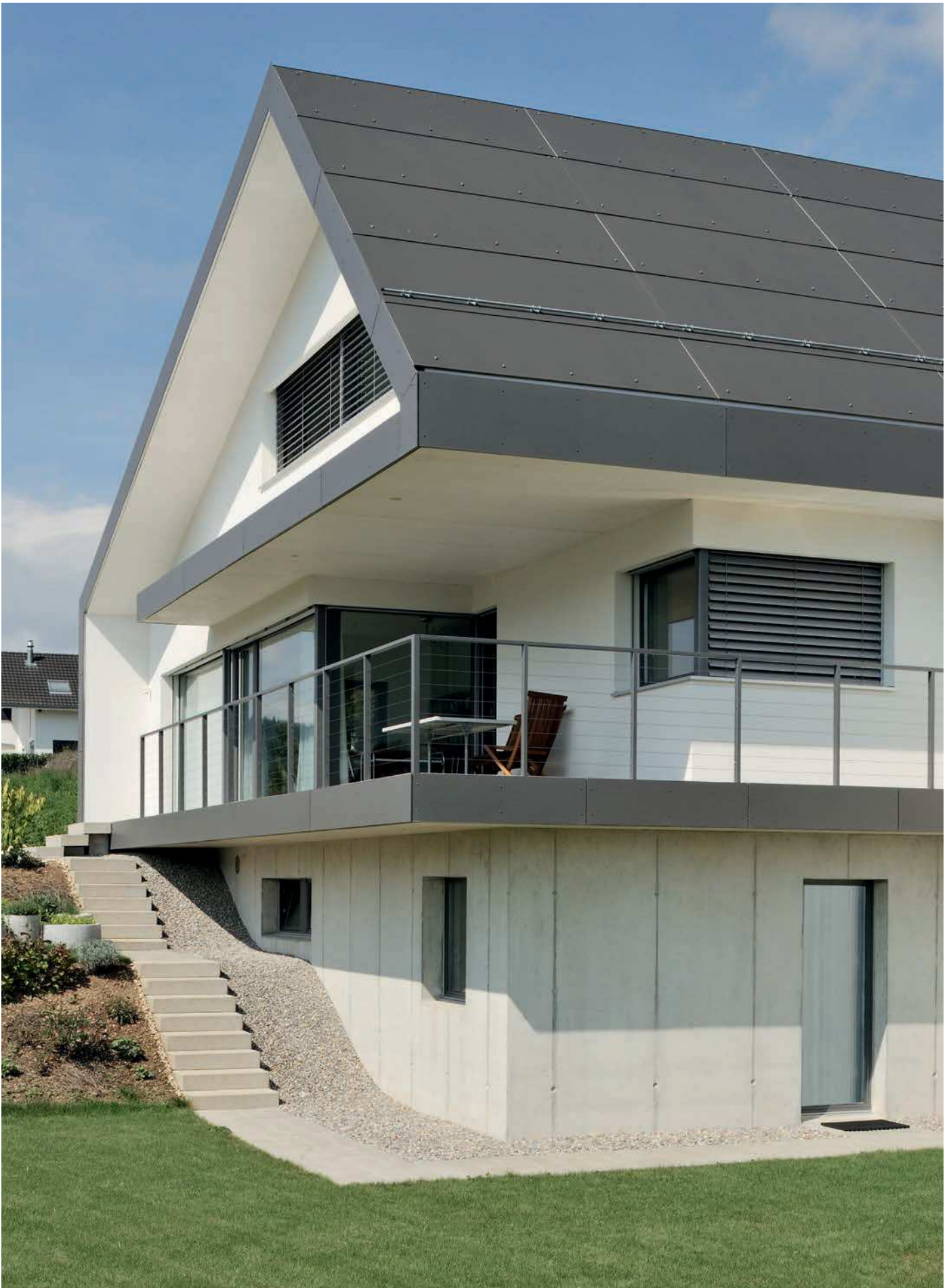
Casa unifamiliare, Liesburg/Svizzera, Architettura: Dreier + Korntheuer Architekten ETH, Büsserach
