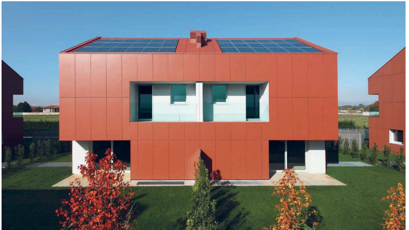
Casa plurifamiliare, Uboldo/Italia, Architettura: Arch. Marco Castelletti, Erba
