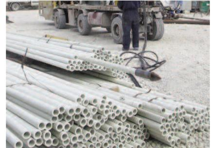
**L'impiego delle barre in vetroresina risulta vantaggioso perché unisce elevati valori di resistenza e l'opportuna necessità di essere spezzate facilmente durante l'avanzamento, in virtù della loro fragilità, dalle stesse attrezzature meccaniche utilizzate nello scavo.**
