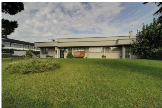
Sede Amministrativa e Produttiva
