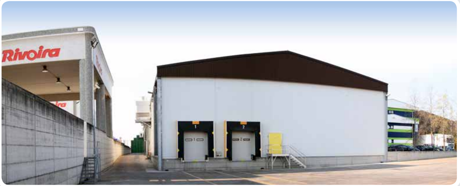
Magazzino logistico: baie di carico in facciata realizzata con pannelli metallici
