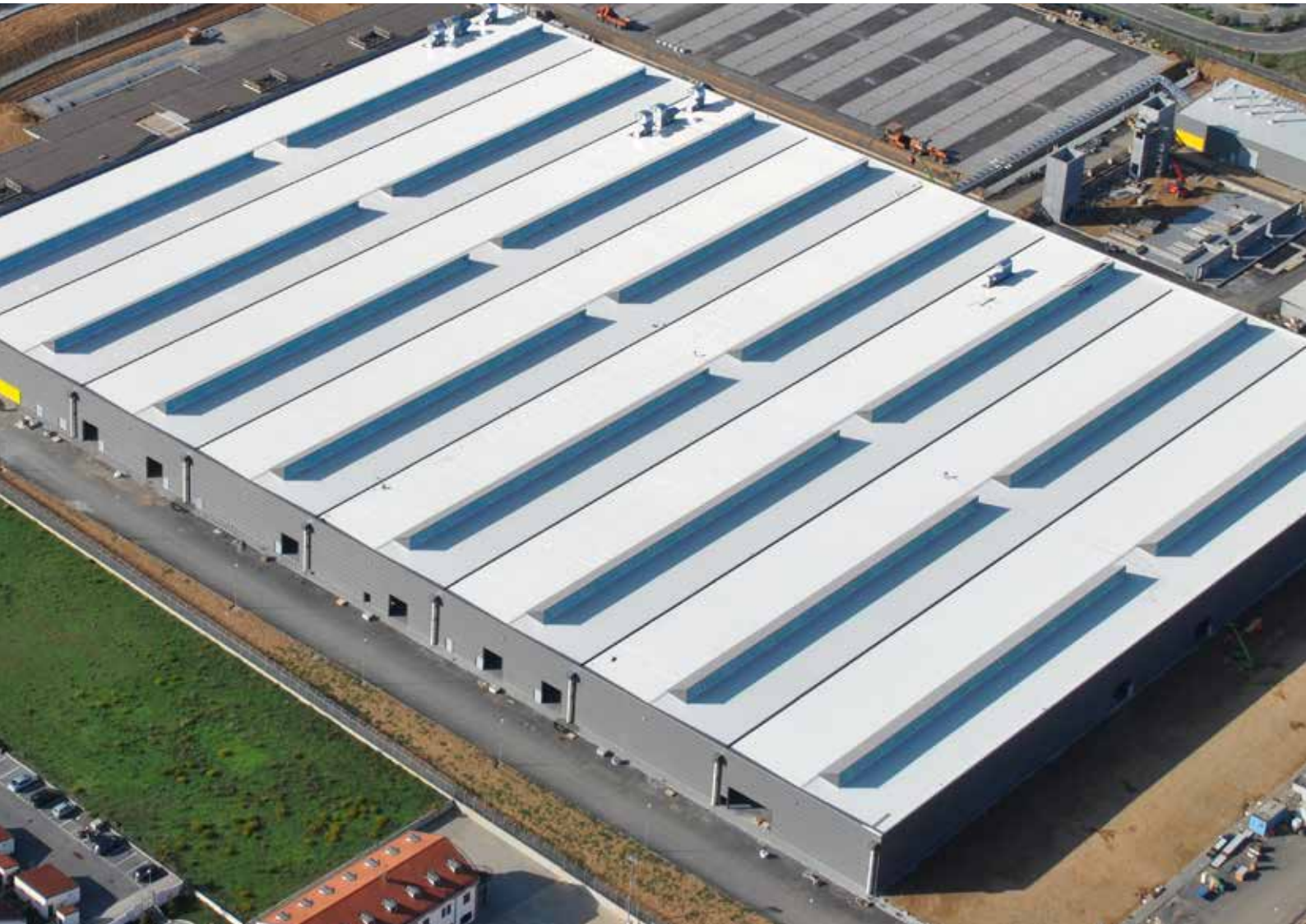
Fabbricato industriale: Pareti e coperture
