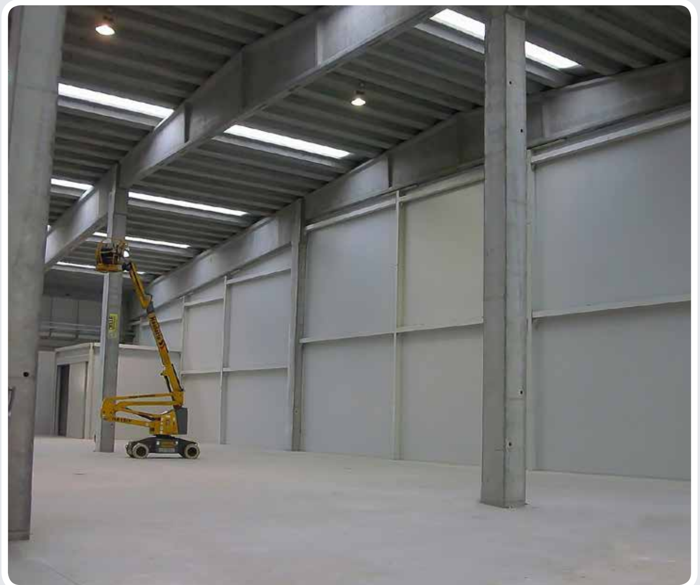
PARETI REI - fabbricato industriale
