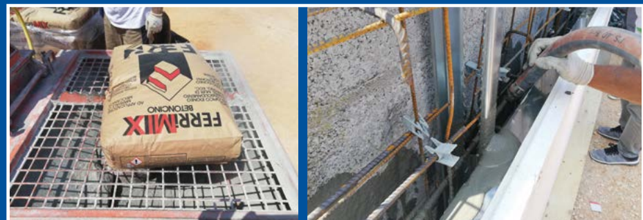
Getto del betoncino strutturale Ferrimix di opportuna resistenza meccanica in funzione della scelta progettuale
