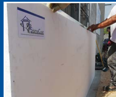
Posa dei pannelli isolanti da cappotto
