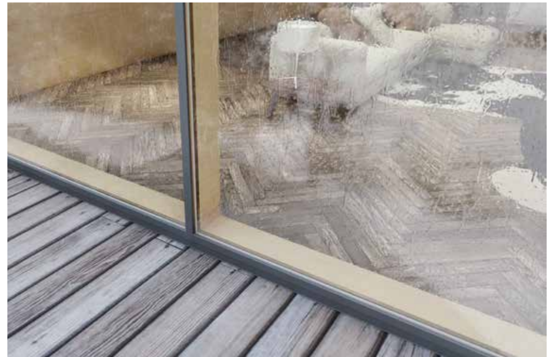
Viste di dettaglio Skyline Facade
