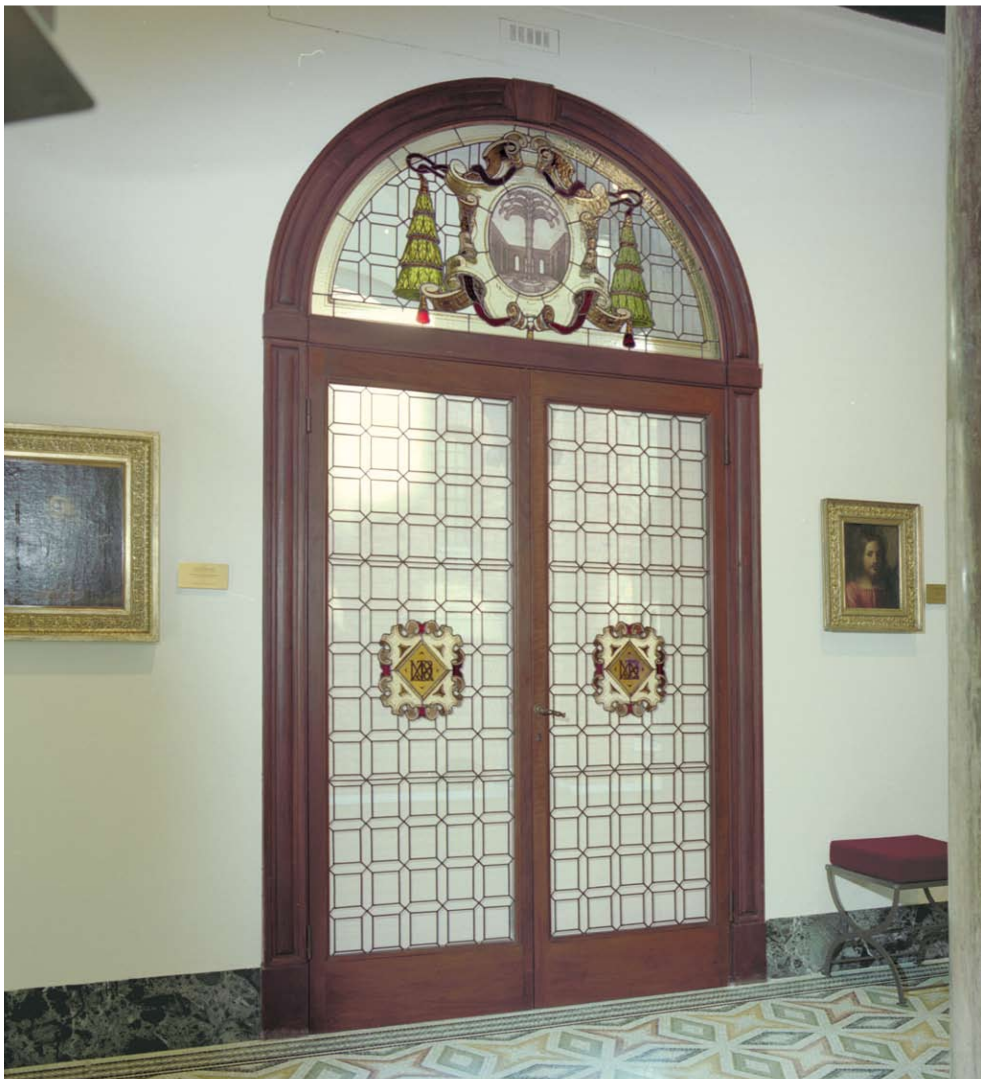
Biblioteca Ambrosiana a Milano Serramento in noce nazionale con restauro delle vetrate
