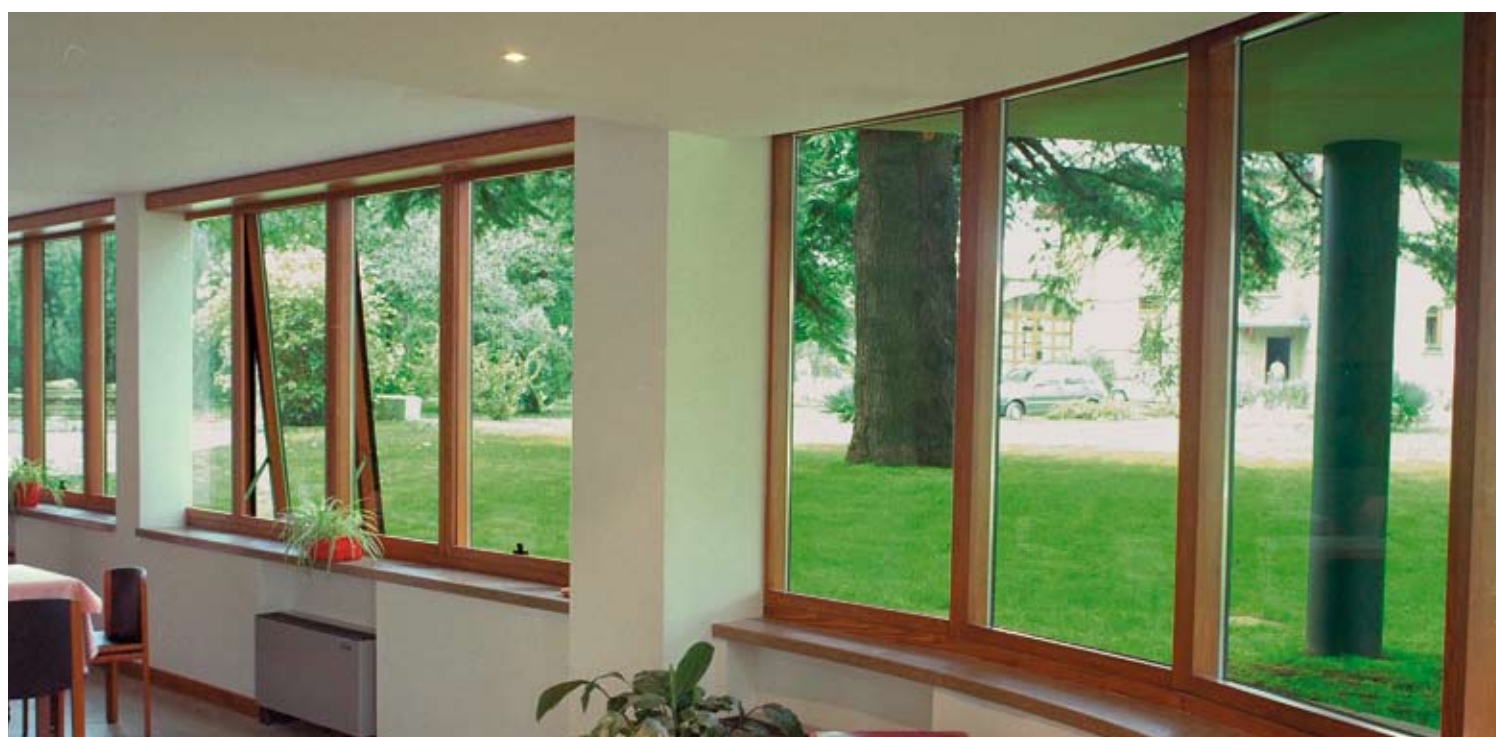
Facciata continua in legno-alluminio Curtain wall: wood-aluminium combination
