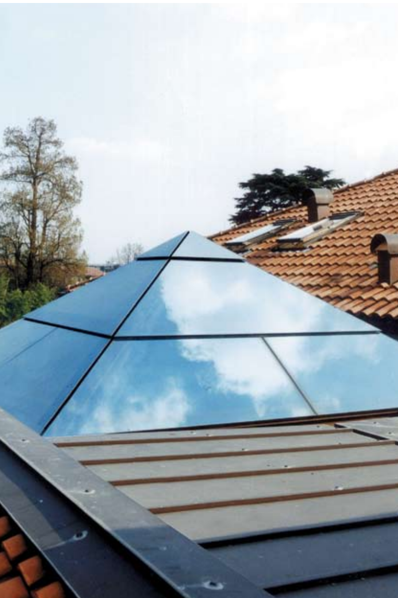
Piramide in legno e vetro con ante apribili motorizzate. Wooden pyramid complete with motor-controlled openings
