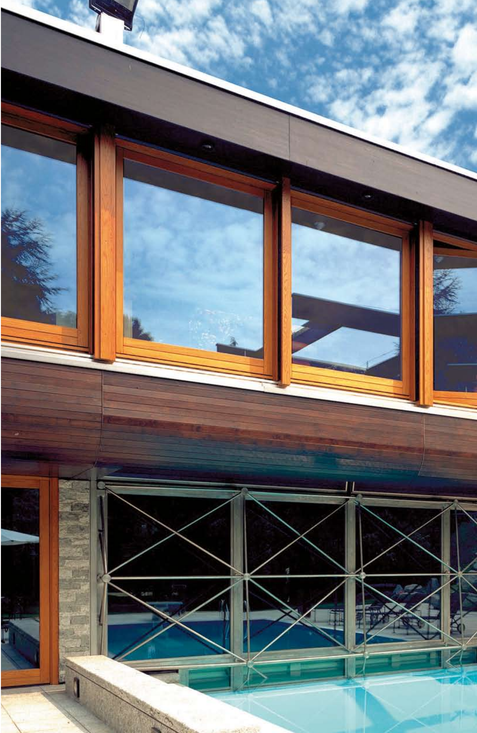
Serramento basculante in acciaio inox tra piscina interna e piscina esterna. Dimensione cm 800 x 380
