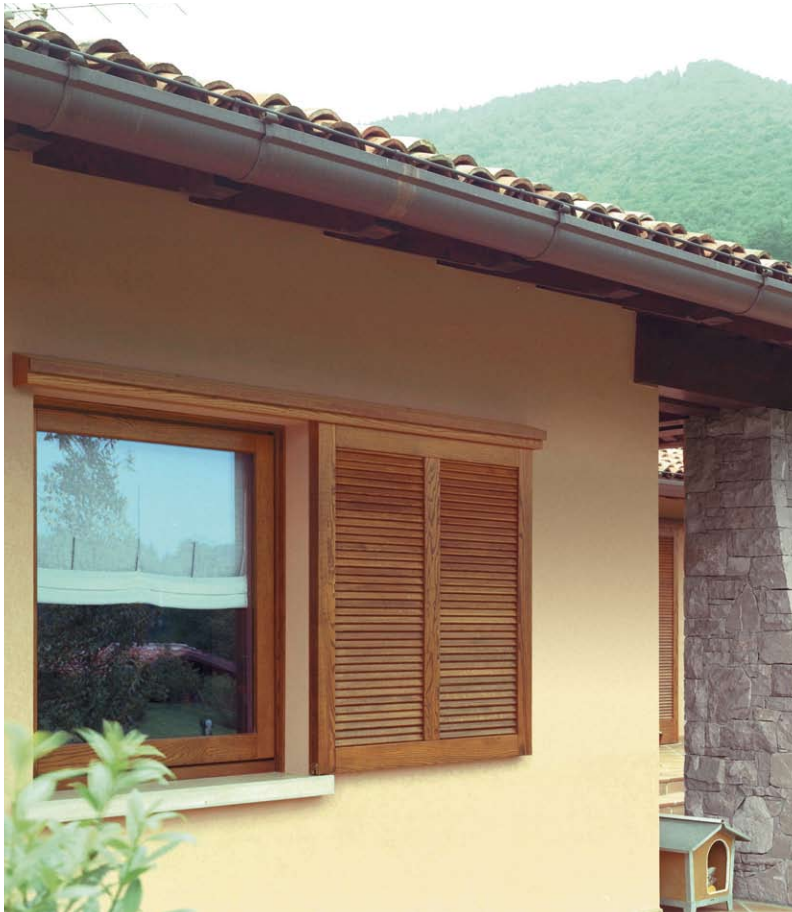
Serramenti SC 70 in rovere con persiane scorrevoli esterno muro motorizzate
