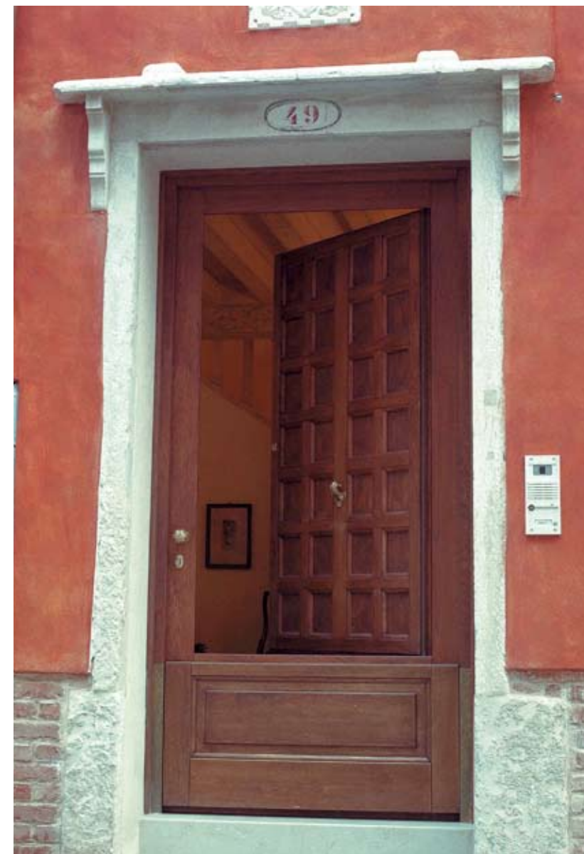
Portone d'ingresso con paratia a tenuta stagna e porta superiore apribile Main entrance complete with waterproof bulkhead and operable upper door
