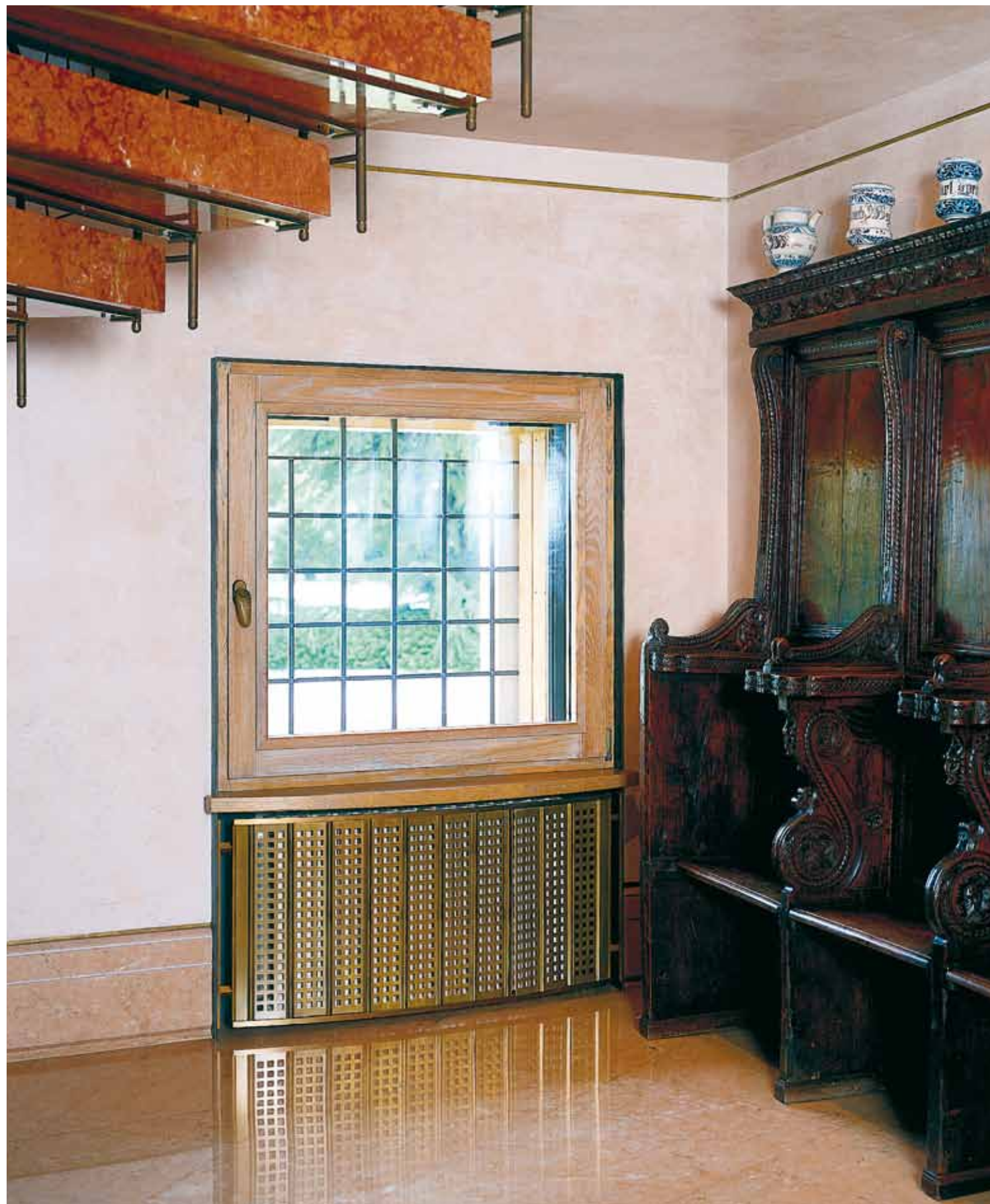
Scuri a libro blindati in legno e acciaio inox Book-fold blinds in wood and stainless steel (armoured)
