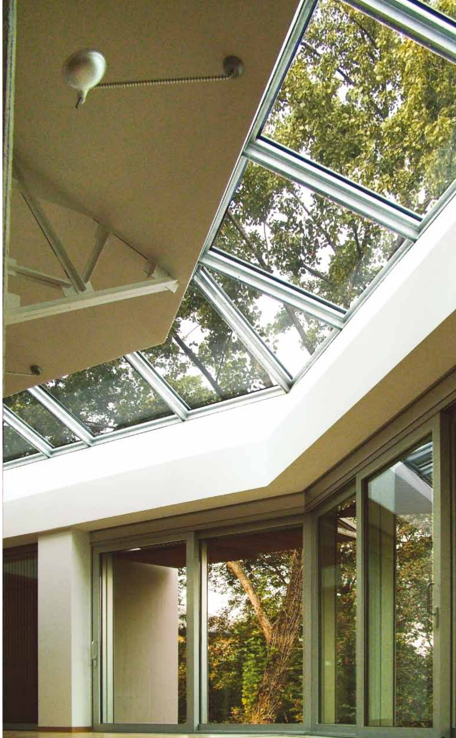
Lucernari fissi in acciaio zincato con profili a taglio termico Fix skylight in galvanized steel (thermally broken)
