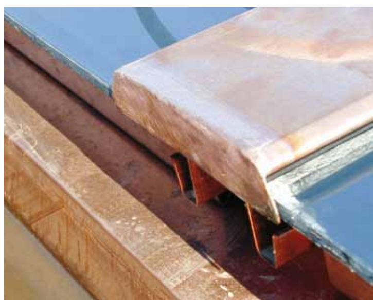
Dettagli in fase di montaggio Detail (installation)
