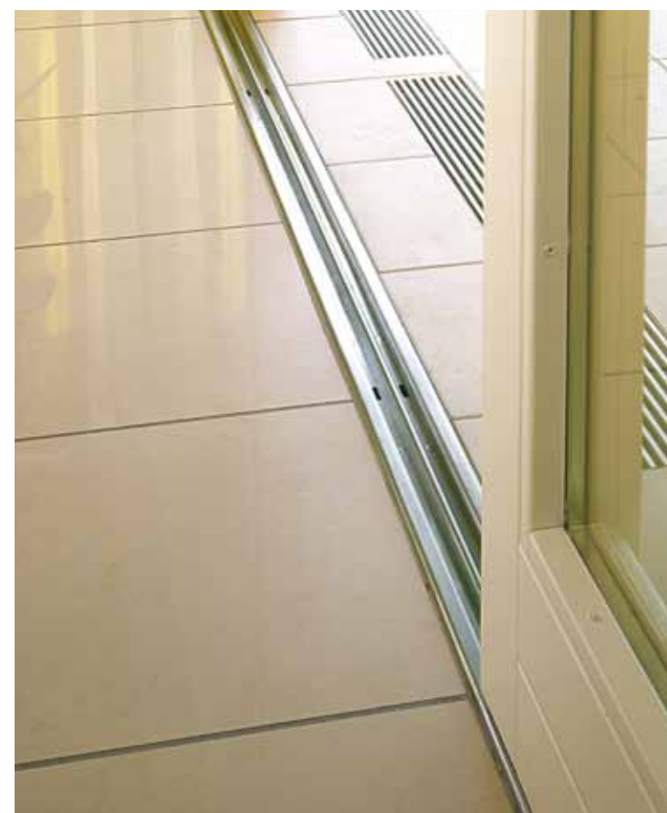
Serramenti scorrevoli con guida in acciaio inox a filo pavimento Sliding windows with flush tracks in stainless steel
