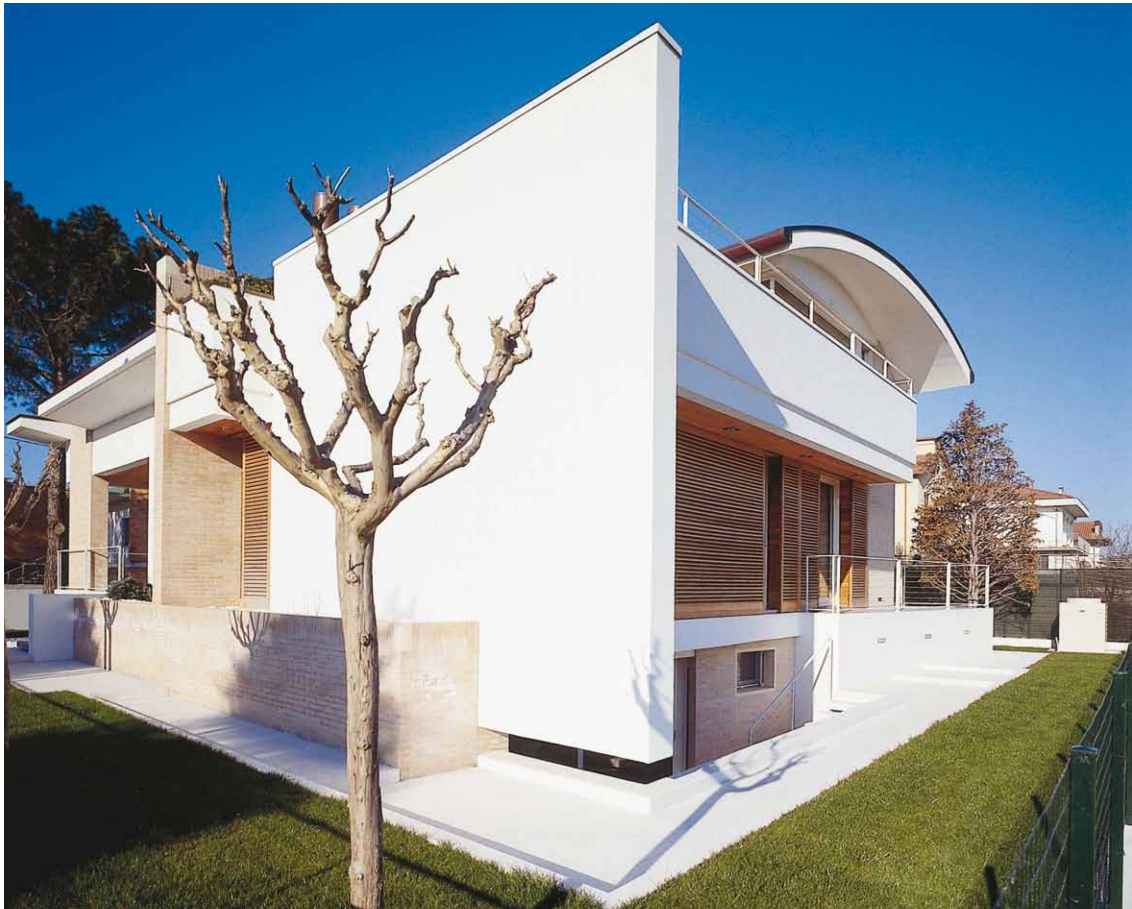
Persiane in cedro scorrevoli motorizzate con rivestimenti esterni - Automated sliding panels in red cedar and external facing
