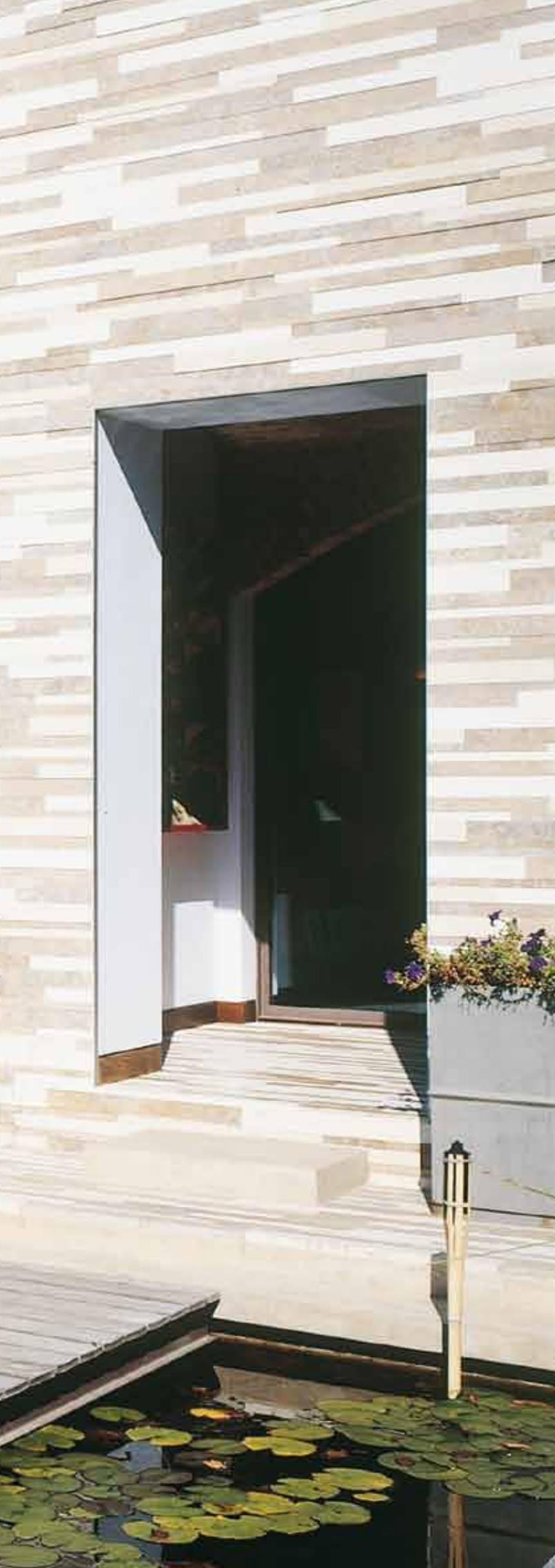
Villa Giugiaro: serramenti in ferro con profili a disegno a taglio termico Thermally broken, custom-designed iron windows
