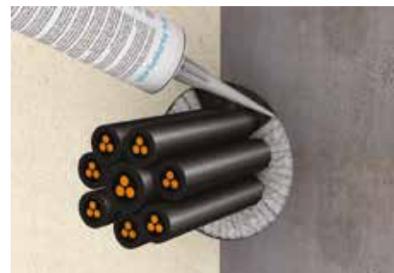
3. Applicare il corretto spessore di sigillante
