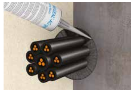
3. Applicare il corretto spessore di sigillante
