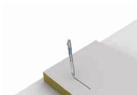
3. Trasferire le misure sul pannello in lana minerale
