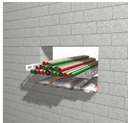
3. Il primo strato di cuscini dovrebbe essere installato sotto i cavi e/o i tubi
