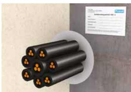
5. Applicare un'etichetta di identificazione
