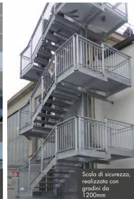
Scala di sicurezza, realizzata con gradini da 1200mm
