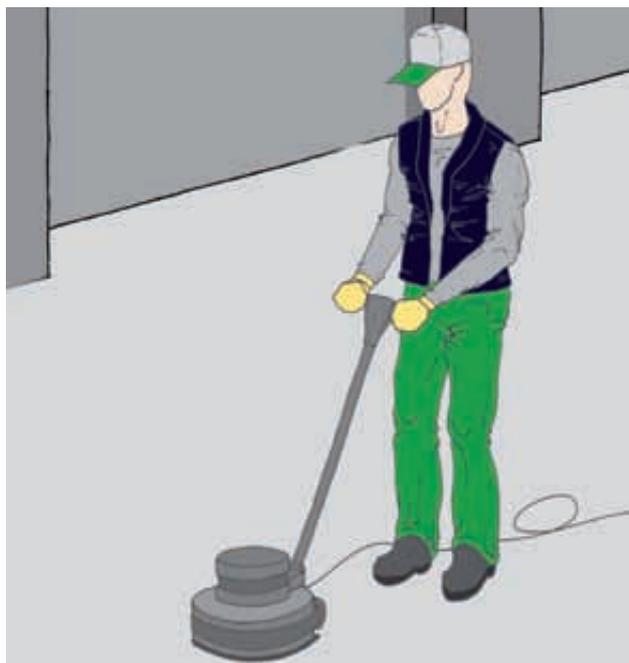
A) Esempio di applicazione su superficie già preparata con Igotan o Nairetan Base, previa scarificazione:
