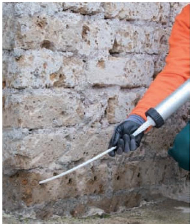
4) Inserire la cannula della pistola all'interno del foro realizzato ed iniettare il Salvamuro Gel. Ristuccare quindi i fori con una malta cementizia.
