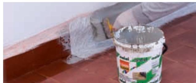
4) Dopo 15 - 30' dall'applicazione del Nai 45, stendere sui verticali una mano di Cemenguaina sovrapponendovi, a fresco, la fibra di vetro. Rivestire, quindi, la fibra con ulteriore Cemenguaina.
