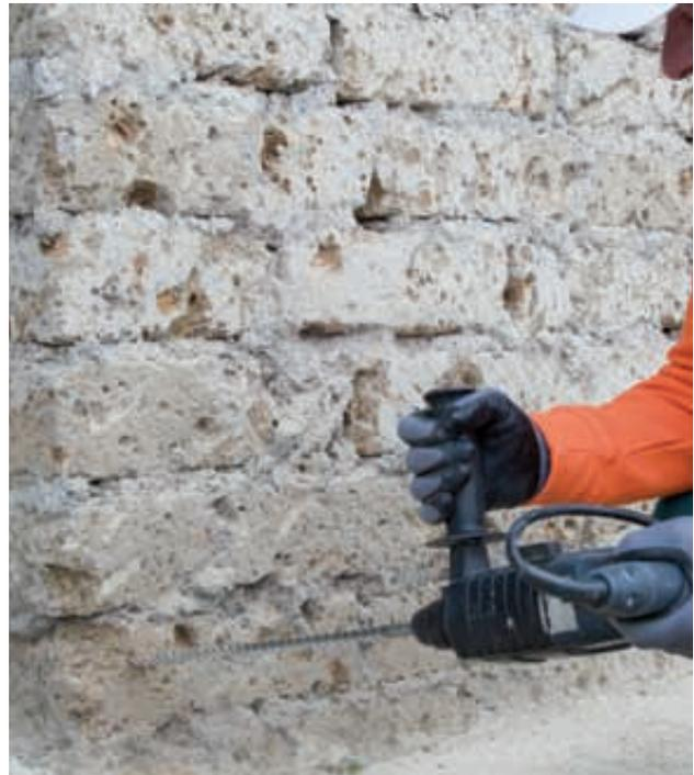
2) La foratura del muro deve avvenire ca. 12 cm sopra la quota più alta del pavimento tra interno ed esterno. I fori dovranno essere realizzati con un'inclinazione di ca. 5°-10° fino a 5 cm circa della fine del muro.
