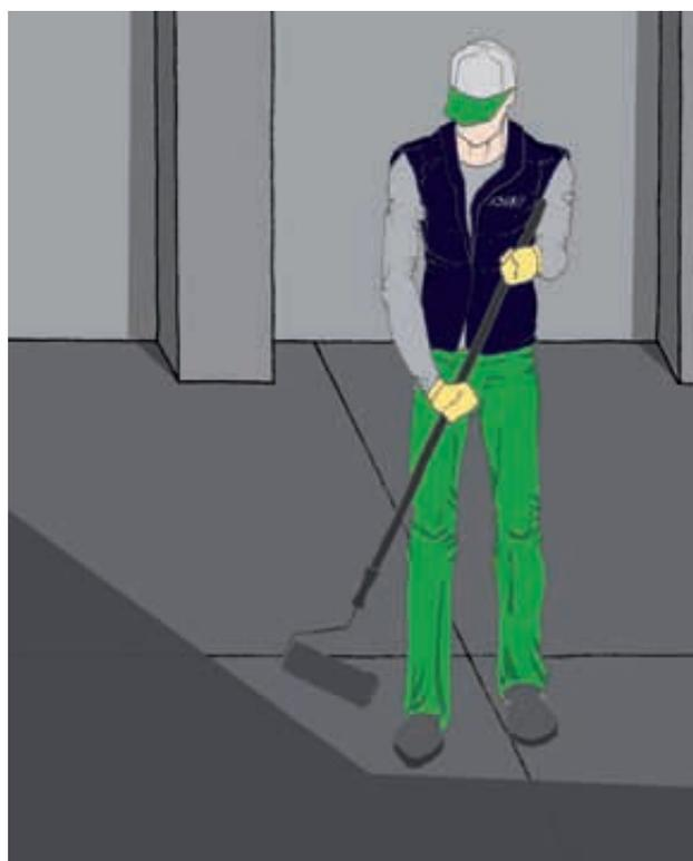
8) Ad asciugatura preparare ulteriore materiale. Applicare la 2ª mano di Nairetan 200 sulla superficie in ragione di ca. 250 g/mq.
