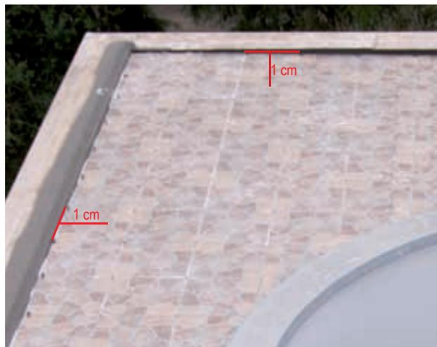
2) Mantenere le piastrelle, lungo il perimetro di tutte le strutture in elevazione, distanti un centimetro dalle stesse.
