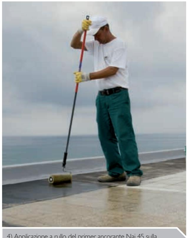
4) Applicazione a rullo del primer ancorante Nai 45 sulla superficie da impermeabilizzare (ed attendere l'asciugatura, circa 30' min in funzione della temperatura esterna).
