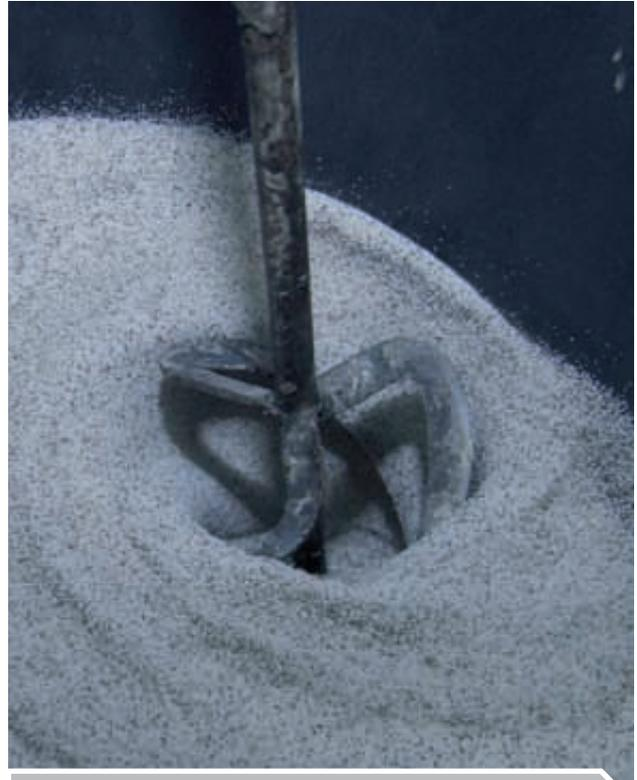
6) Miscelazione dei componenti A e B del Nairetan Pharm 1<sup>a</sup> mano con i quarzi ceramizzati di colore desiderato (componente C).
