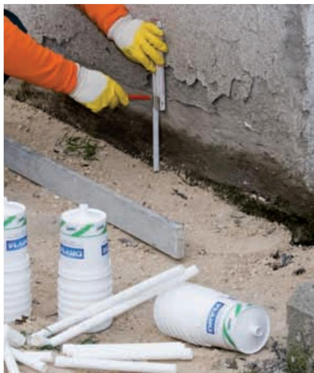
2) Segnare una linea parallela al pavimento ad un'altezza di 20 cm e marcare ove verranno realizzati i fori. Il primo foro a 7/8 cm dall'angolo e gli altri a 15 cm di distanza l'uno dall'altro.
