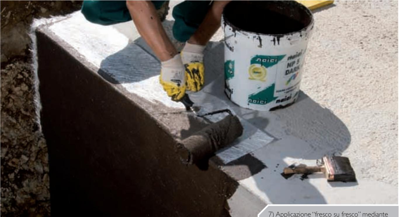
7) Applicazione "fresco su fresco" mediante l'utilizzo di un rullo cordonato pelo lungo.
