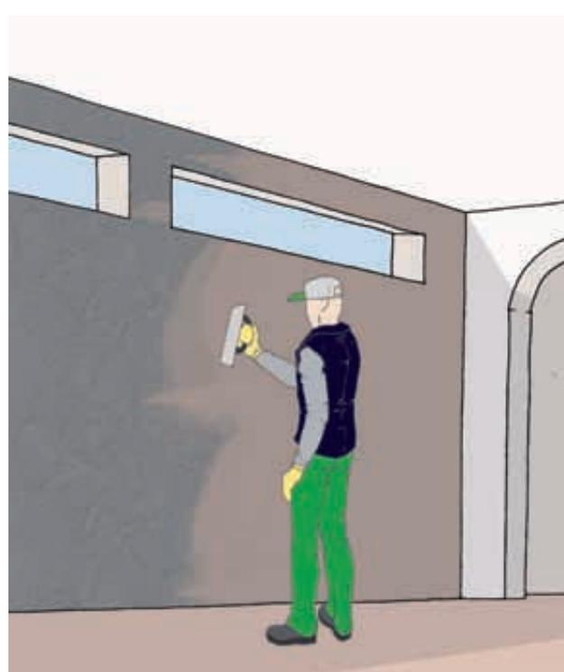
4) Rinzafo della superficie mediante l'utilizzo di Nai Cm Sanamuro.
