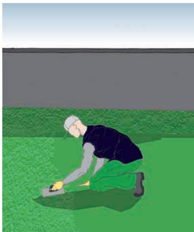
6) Procedere alla stesura del Ceramic 1<sup>a</sup> mano anche sulla superficie orizzontale con spatola di acciaio. Rasando a zero la superficie in modo che la dimensione del quarzo sia lo spessore del rivestimento.
