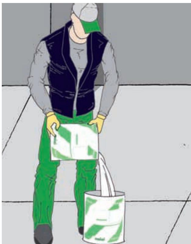
3) Primerizzazione: versare il componente B del primer Nai 70 nel componente A.
