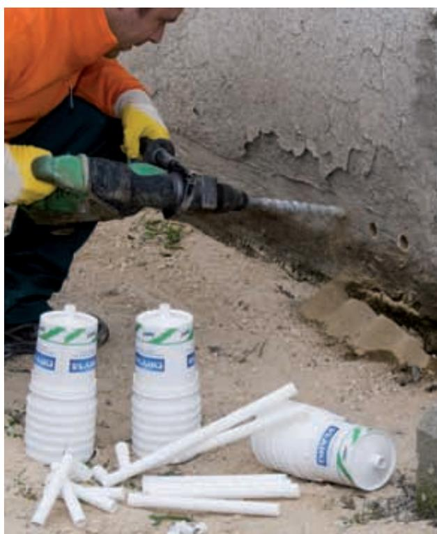
3) Forare la struttura mediante trapano a percussione, per una profondità di circa i 4/5 dello spessore del muro (inclinazione del foro di ca. 5°-10°).
