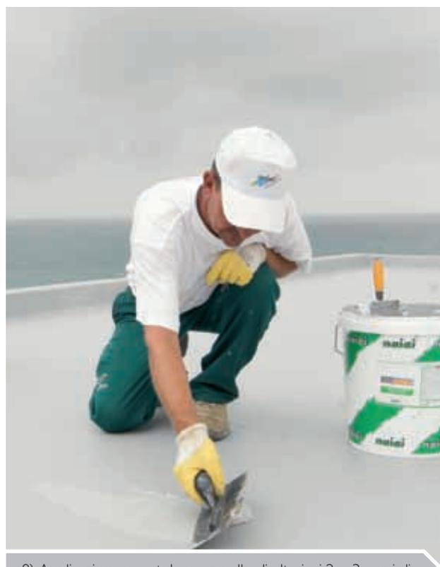
8) Applicazione a spatola o pennello di ulteriori 2 o 3 mani di Fibrogaina-S a mani incrociate per un consumo medio non inferiore ai 2 kg/mq.
