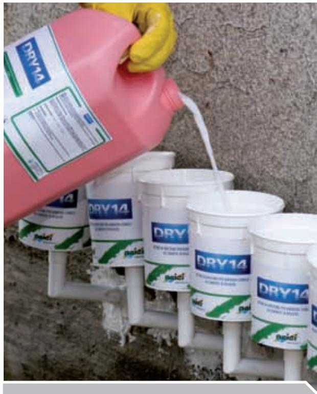
6) Riempire i contenitori ad imbuto con il quantitativo necessario di Dry I4 e tenendo conto di effettuare il riempimento due volte a distanza di 24 ore.
