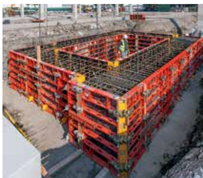
La robusta cassaforma per pareti DOMINO è particolarmente adatta per la realizzazione delle fondazioni.
