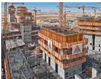
Se abbinata al sistema di ripresa con guide RCS, la cassaforma VARIO GT 24 consente di realizzare anche i vani scala e ascensore dei grattacieli.
