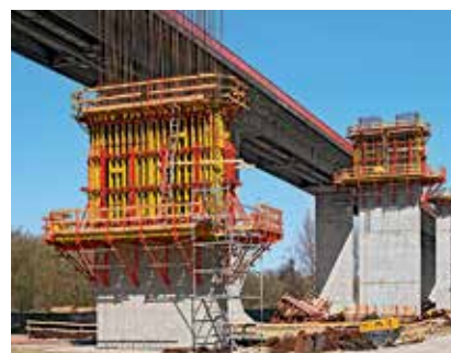
Nella costruzione delle pile dei ponti, la cassaforma VARIO GT 24 è spesso montata su mensole di ripresa.
