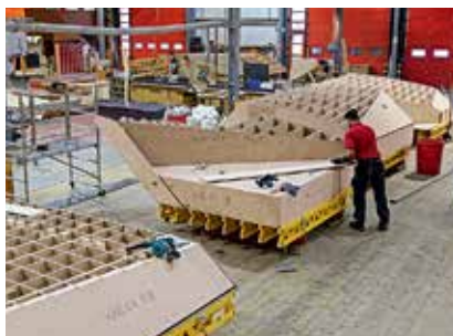
Per realizzare elementi in cemento armato dalle forme complesse, PERI propone moduli di cassaforma 3D progettati e assemblati su misura.
