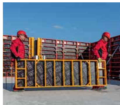
In assenza di gru, può essere utilizzata la variante DOMINO Alu, realizzata in alluminio.
