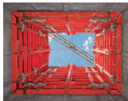
L'elemento di disarmo TRIO permette di sollevare rapidamente unità complete di cassaforma interna di vani, creando uno spazio di 30 mm su ogni lato tra la cassaforma e il vano.
