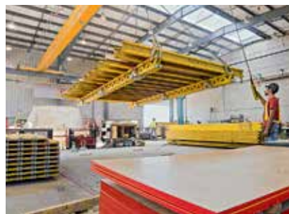
Il preassemblaggio di casseforme a travi per pareti, moduli di cassaforma 3D o anche impalcature di sostegno per carichi elevati, destinate al settore delle infrastrutture, può essere effettuato anche nello stabilimento PERI.
