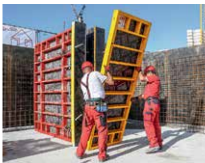
Gli elementi a telaio TRIO in alluminio sono protetti da uno strato di vernice di colore giallo e possono essere movimentati a mano.
