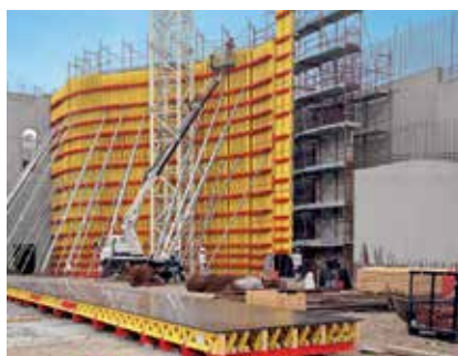
I pannelli di rivestimento di grande formato FinPly Maxi sono ideali per realizzare superfici in calcestruzzo a vista di ottima qualità.
