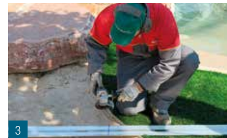
3 Taglio a misura con flessibile. Cutting to size with a flexible saw. Mit Flex zuschneiden. Découpe avec meuleuse d'angle.
