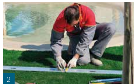
2 Misurazione lunghezza e segnatura per taglio a misura. Measuring the length and marking a sign for cutting. Längen- und Signaturmaß für das Zuschneiden. Mesure de longueur et de marquage pour découpe.
