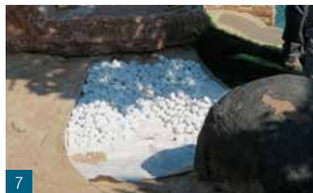
7 Stesura del telo in tessuto non tessuto di protezione. Laying of the non-woven protective cloth. Verlegung eines Vlieschutzgewebes. Etendre du bache en tissu non tissé de protection.
