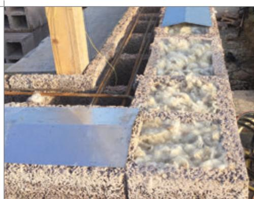
■ Esempio di posa in opera di un SUPERBLOCCO 50 in legno-cemento con isolamento ecologico ad inserimento in LANA DI PECORA. (super ecologico e super performante).
