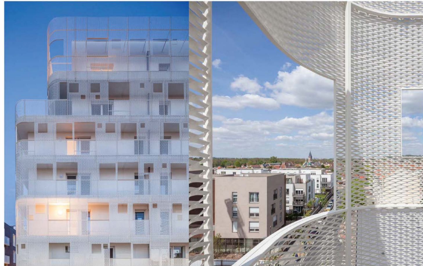
Logements sociaux Croix Blanche (Vigneux sur Seine) - Margot-Duclot Architectes Associés Lagun 115M
