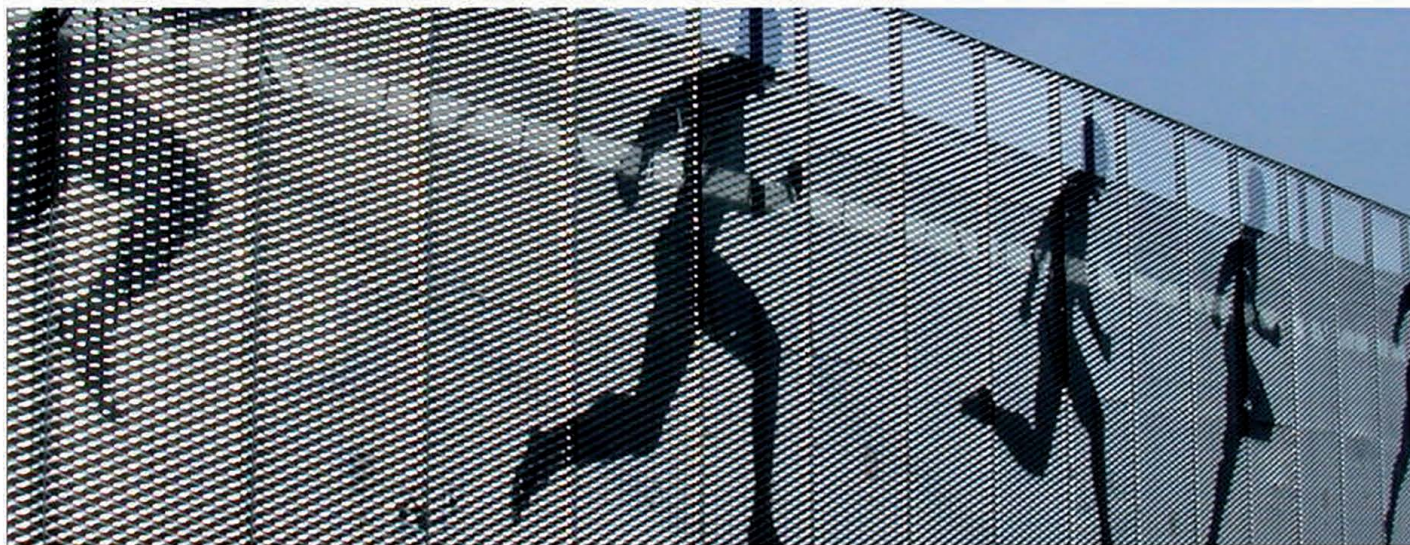
Complexe sportif (Vénissieux ) Atelier sur les quais, architectes Crystal 200M
