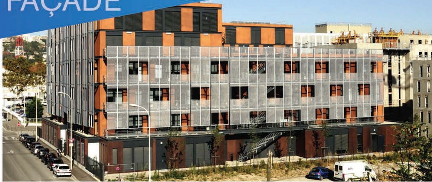
Bureaux Atrium (Gerland) - Soho Architecte - Photo : Pierre Le Chatelier Oxygene 200S
