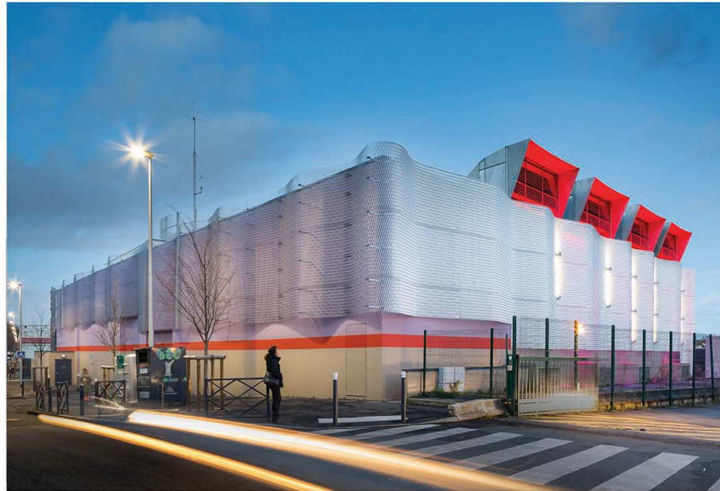
Usine de ventilation (Nogent sur Marne) - Aden Architecture - Photo (c) : Sergio Grazia Crystal 200M
