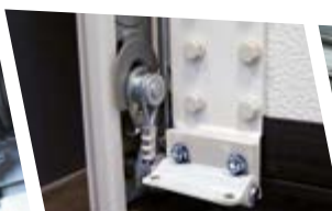
Paracadute cavi Cable break safety device Seilbruchsicherungsvorrichtung
