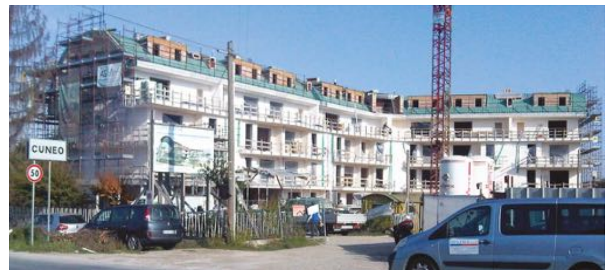
Intervento 36 alloggi a CUNEO - 2010
