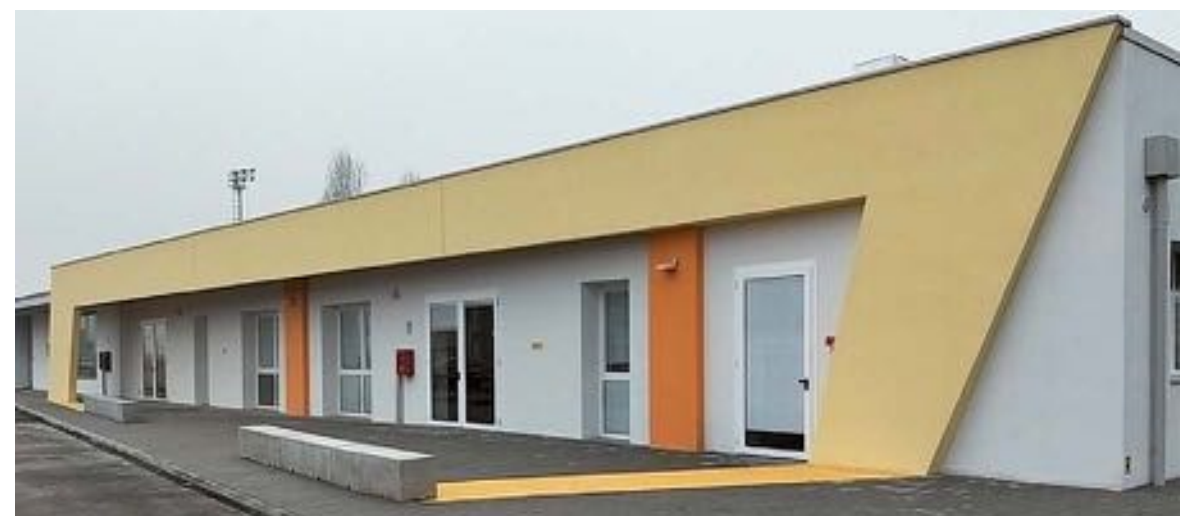
Edificio scolastico a SAN PROSPERO (MO) - 2019
