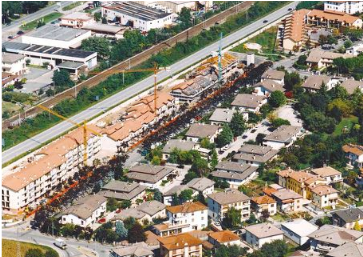
Intervento di 150 alloggi a VICENZA - 2001
