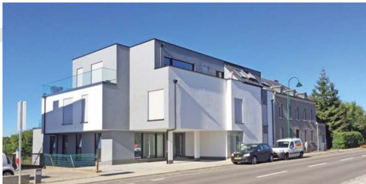
Complesso residenziale plurifamiliare in LUSSEMBURGO - 2015
