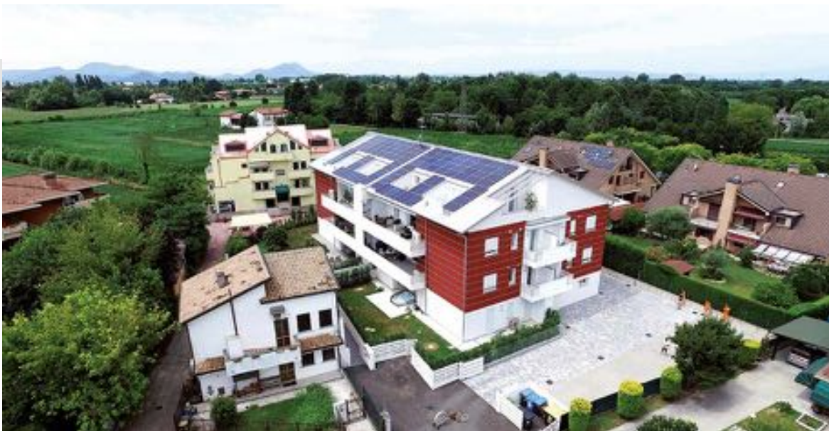
Edificio residenziale di 15 alloggi a MONTA' (PD) - 2017
