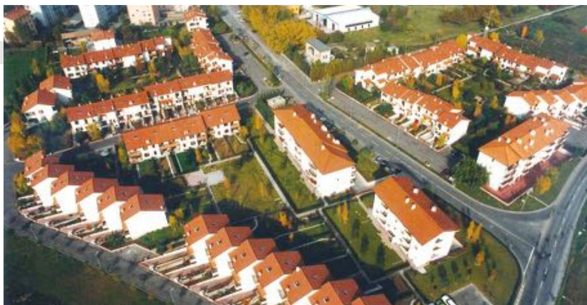
Intervento di 110 abitazioni a FIDENZA (PR) - 1985
