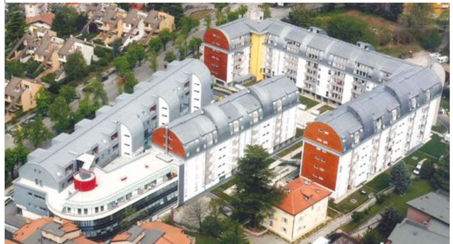
Intervento di 160 alloggi a ROVERETO (TN) - 2004
