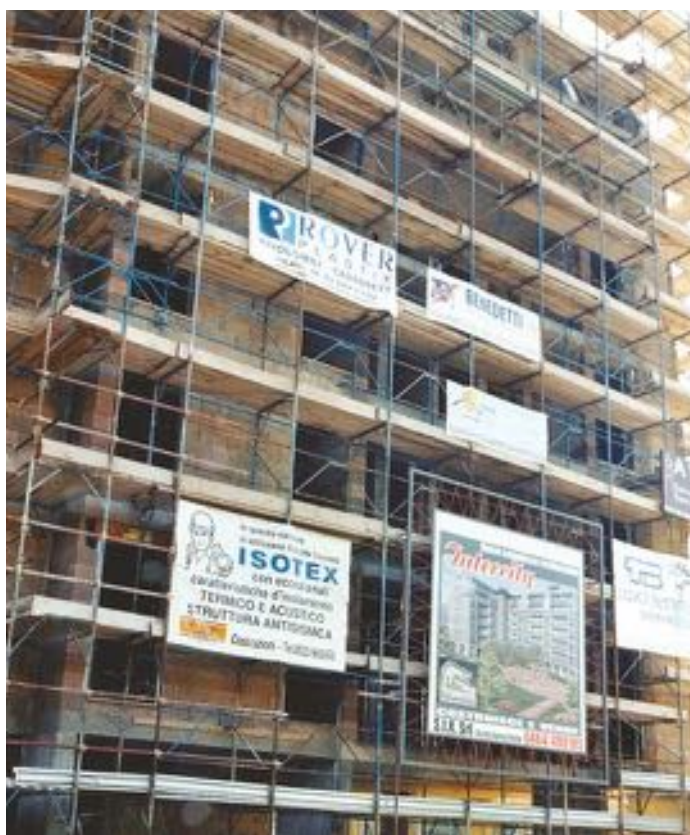
Intervento di 160 alloggi a ROVERETO (TN) - 2001
