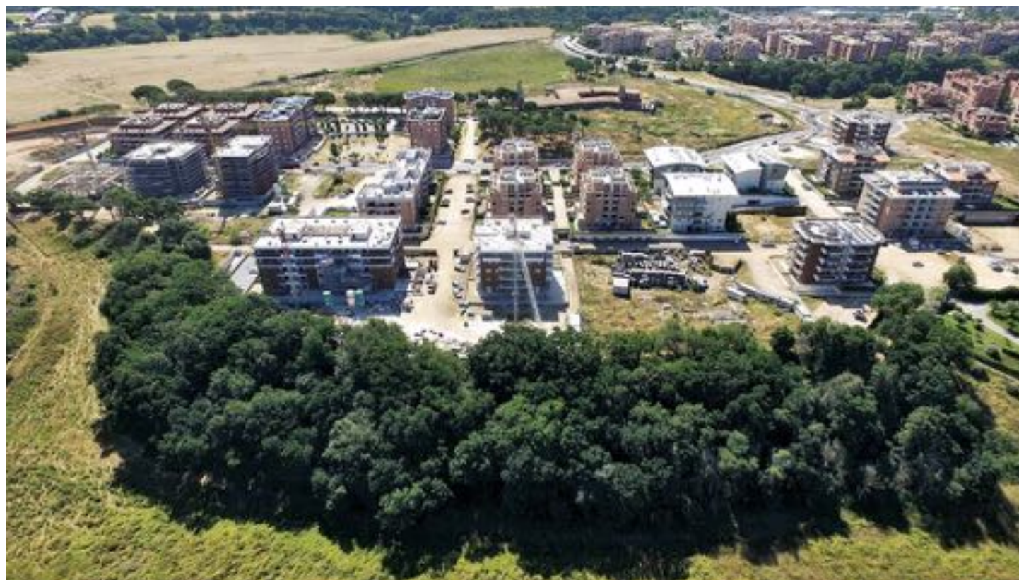
Quartiere residenziale 120 alloggi a ROMA - 2016
