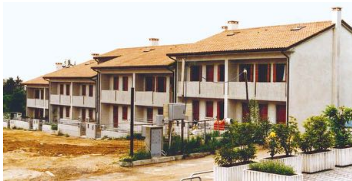
Intervento ville a schiera a PADERNO (TV) - 1994
