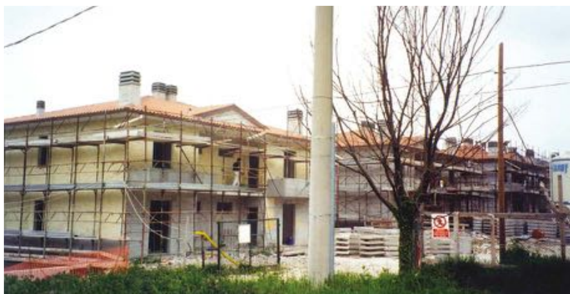
Intervento residenziale a GUALDO TADINO (PG) - 1995
