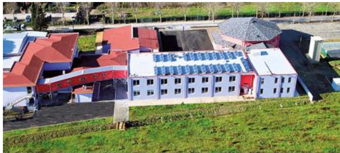
Edificio Scolastico a MASSAROSA (LU) - 2015
