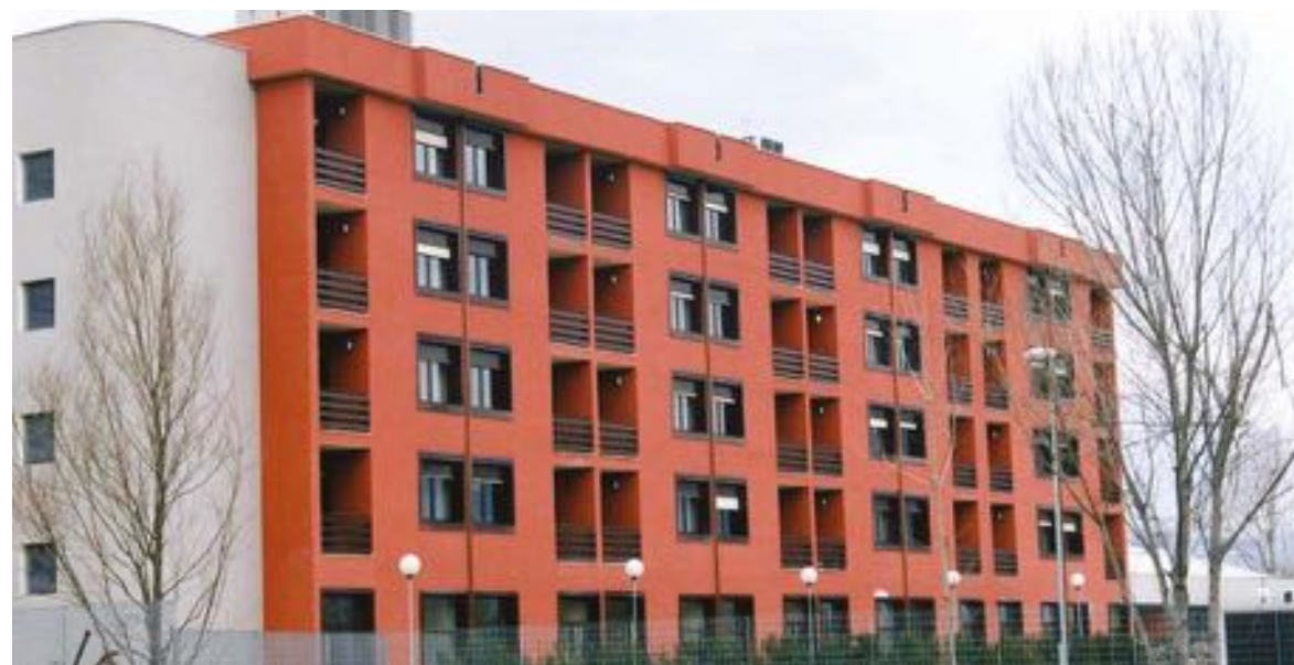
Intervento di 160 alloggi a PISA - 1999
