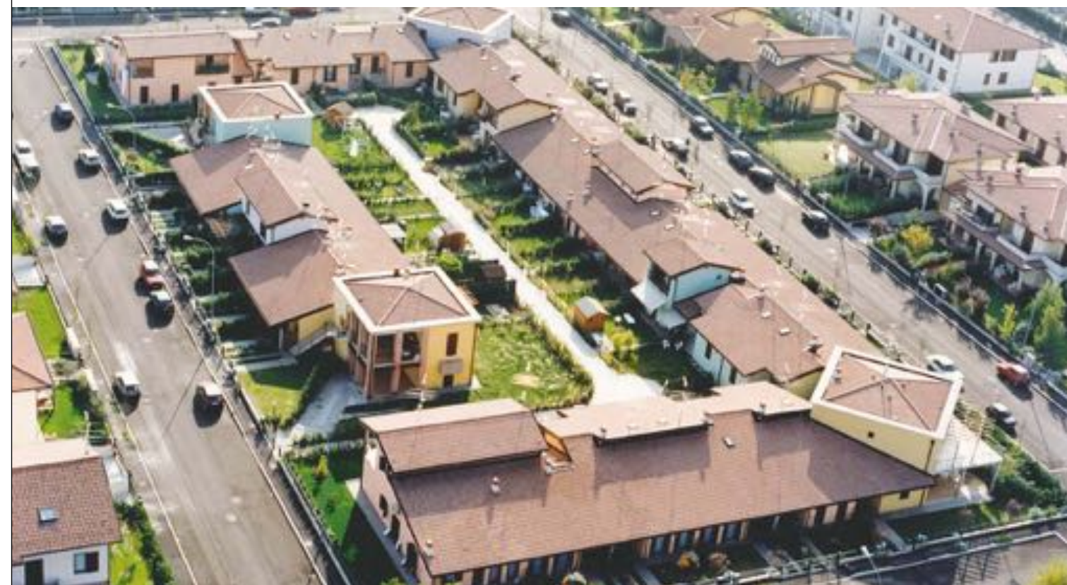
Intervento di 50 abitazioni a BRESCIA - 1994
