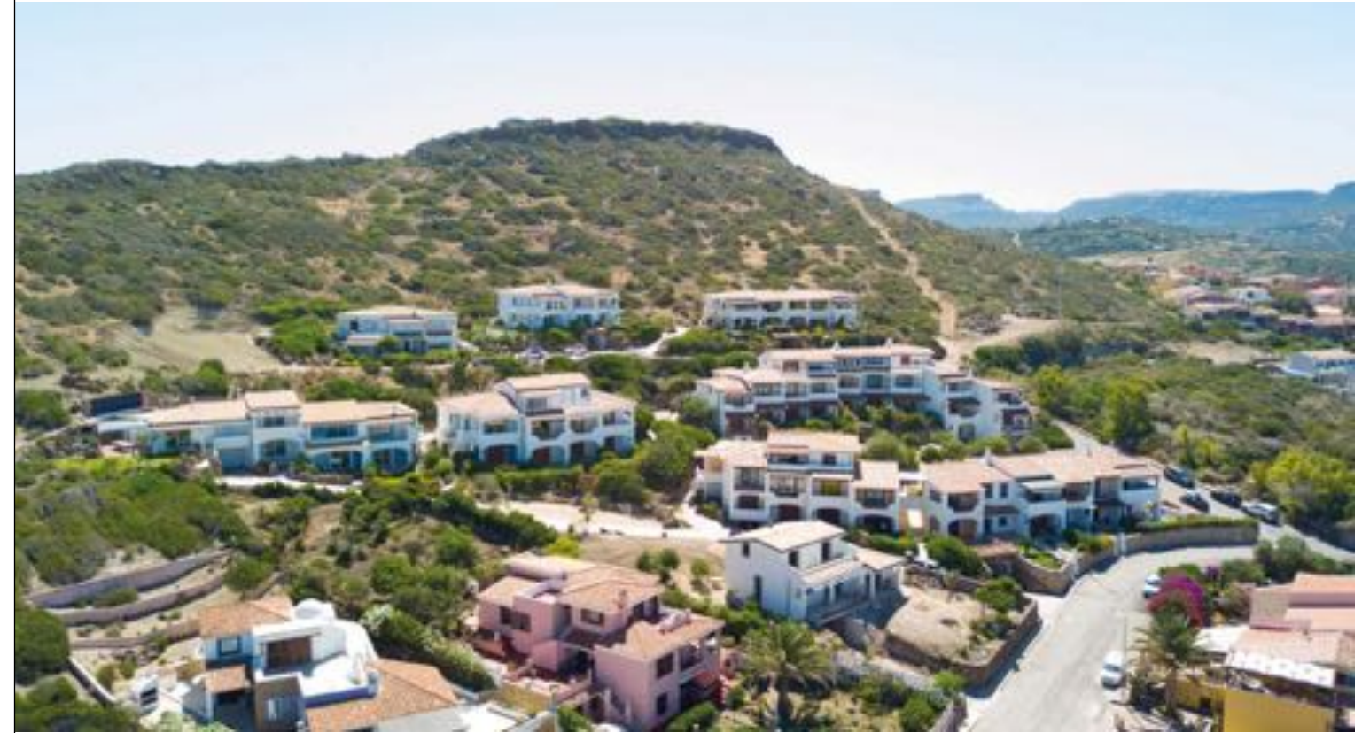
Complesso residenziale di 100 alloggi a CASTELSARDO (SS) - 2016
