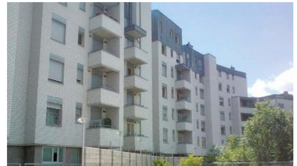
Intervento palazzina 6 piani a BOLOGNA - 2008
