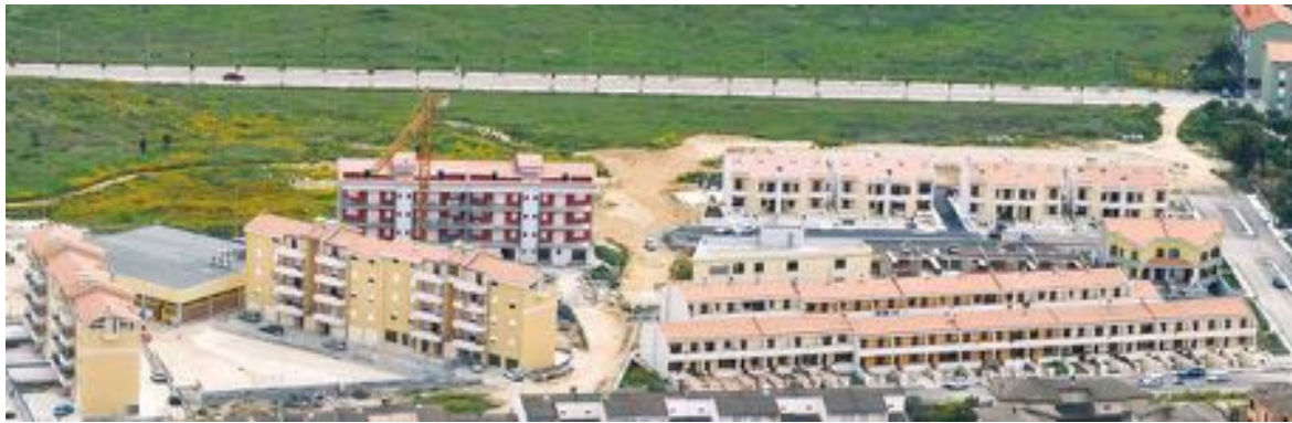
Intervento di 200 alloggi PORTO TORRES (SS) - 2004-2007
