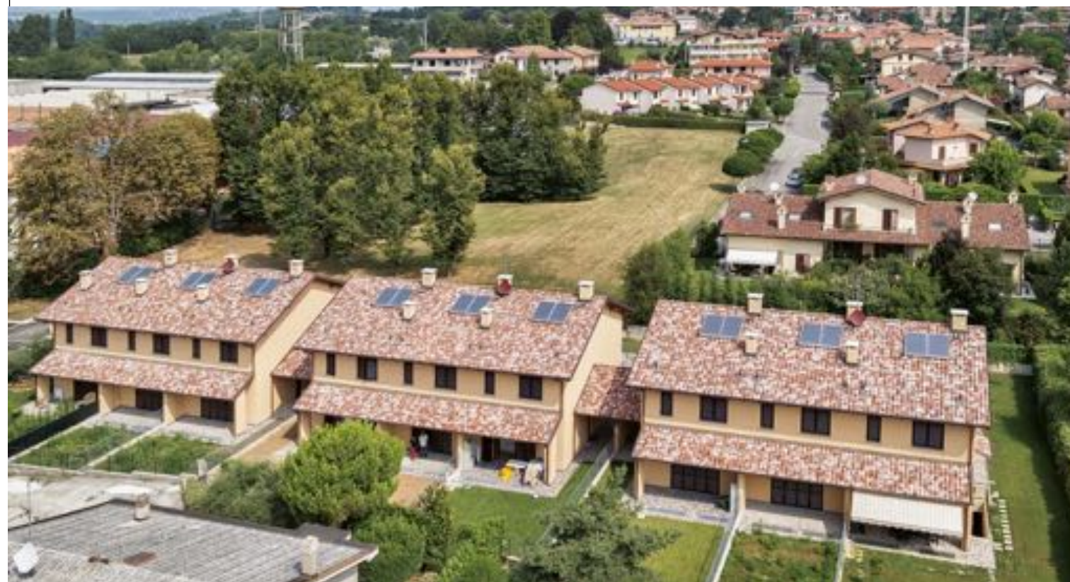
Intervento 9 alloggi BESANA BRIANZA (MB) - 2010
