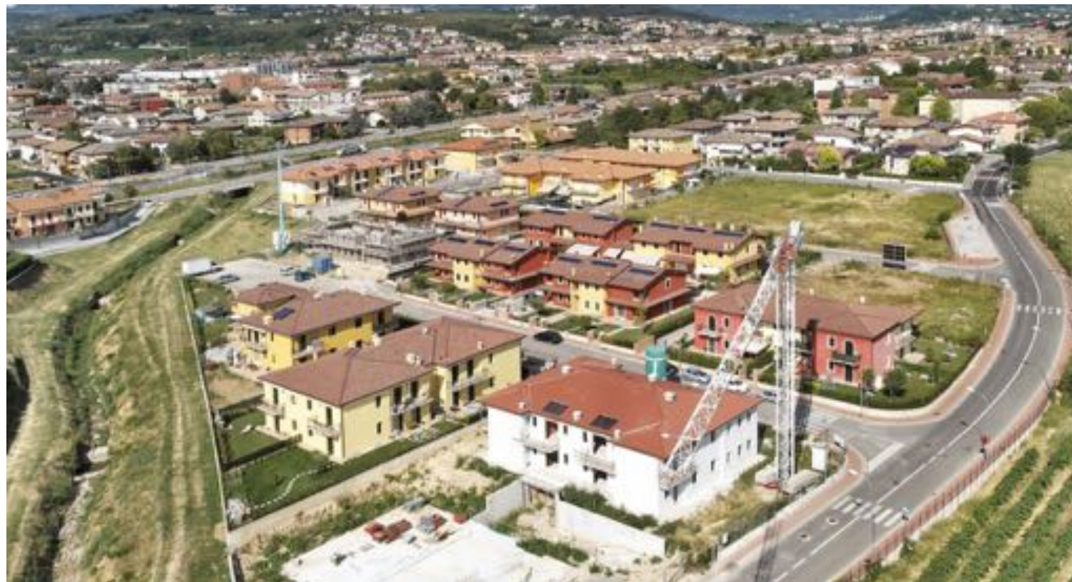
Intervento 20 alloggi a CALDIERO (VR) - 2009
