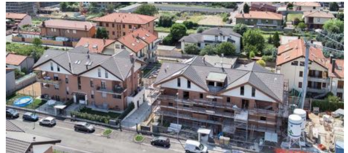
Intervento realizzato a CASOREZZO (MI) - 2010
