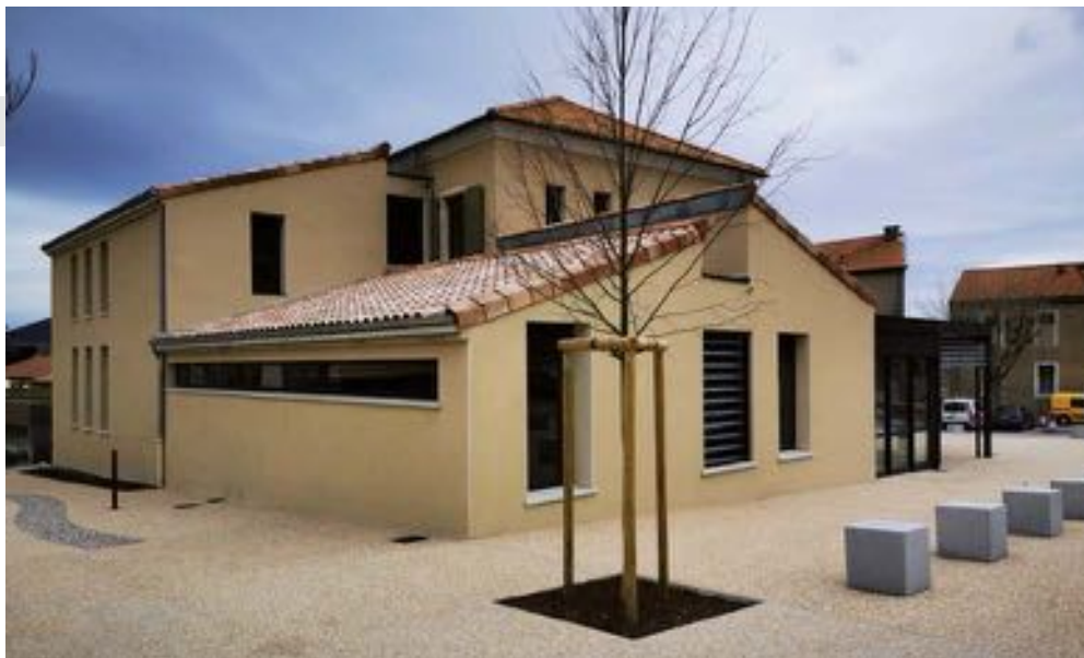
Centro medico realizzato a SAINT MONTAN - (FRANCIA) - 2019
