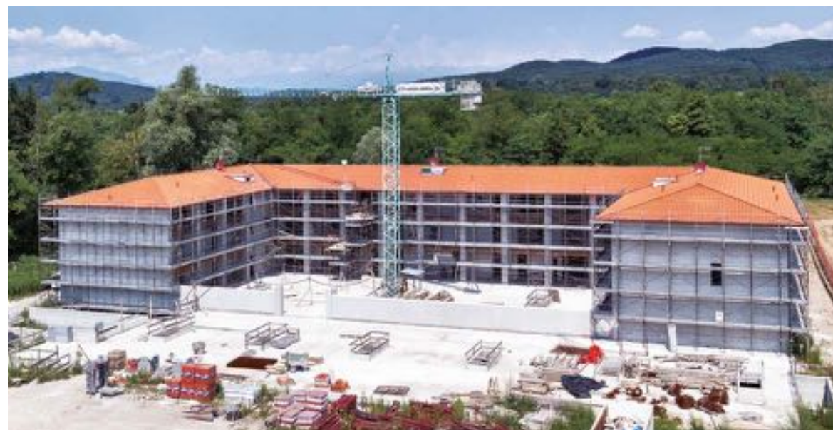
Intervento realizzato a SESTO CALENDE (VA) - 2011
