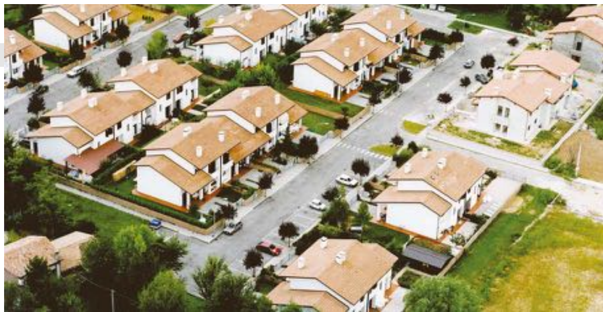
Intervento di 30 alloggi a VICENZA - 1989
