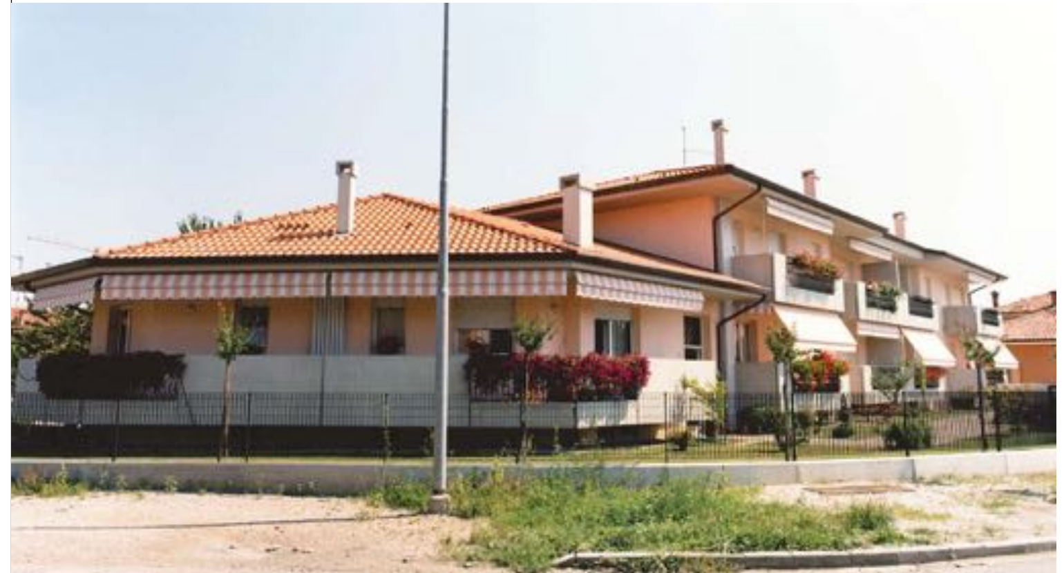
Intervento di 10 alloggi a UDINE - 1994
