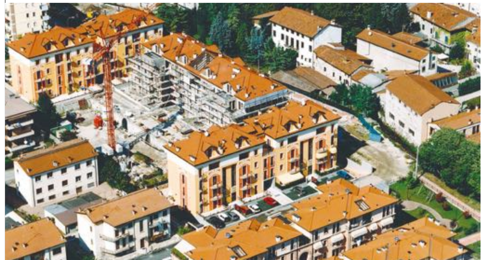
Intervento di 150 alloggi a VICENZA - 2001
