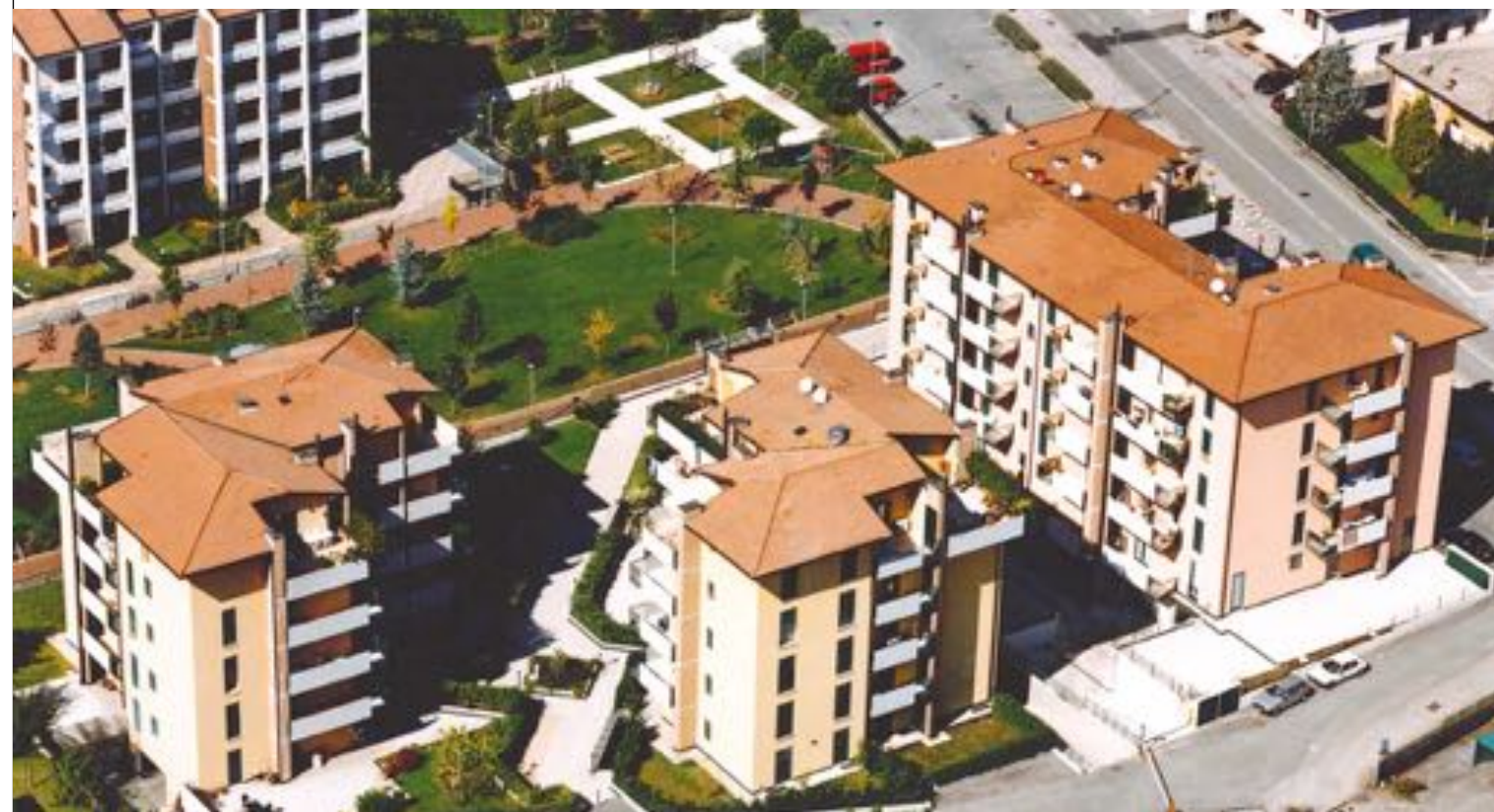
Intervento di 100 alloggi a VICENZA - 1998
