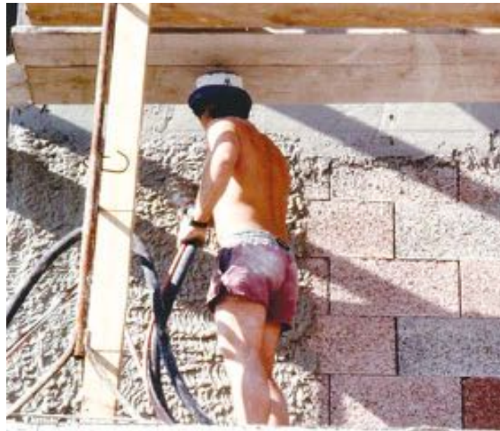
Applicazione di intonaci premiscelati e tradizionali
