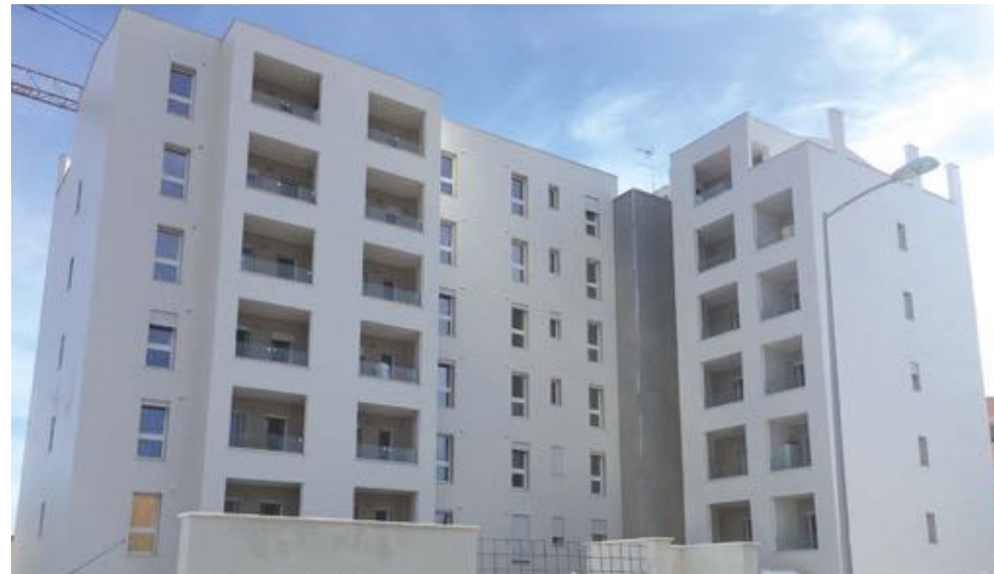
Edificio residenziale 7 piani a SELARGIUS (CA) - 2017
