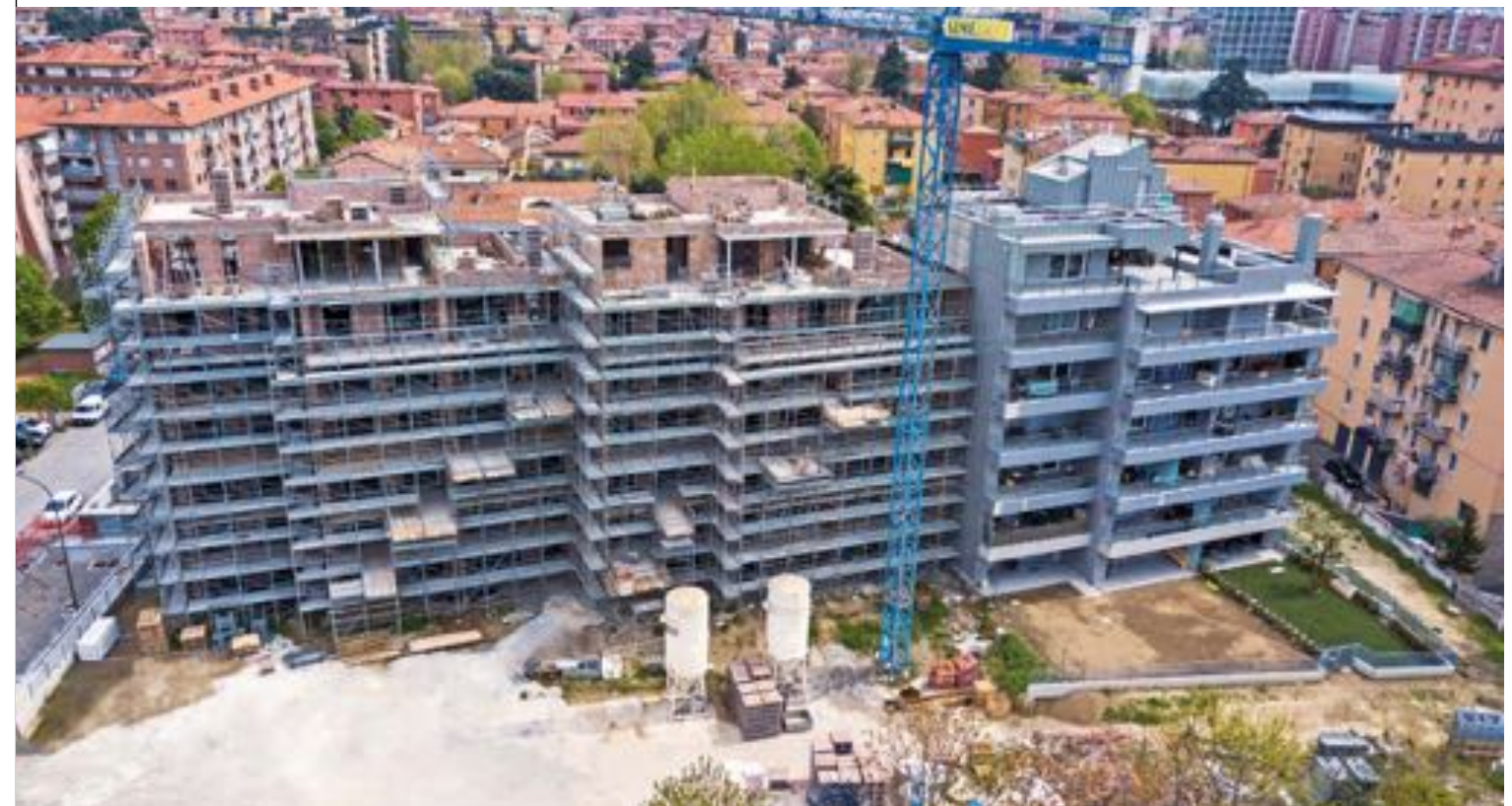
Intervento di 3 palazzine 7 piani a BOLOGNA - 2019
