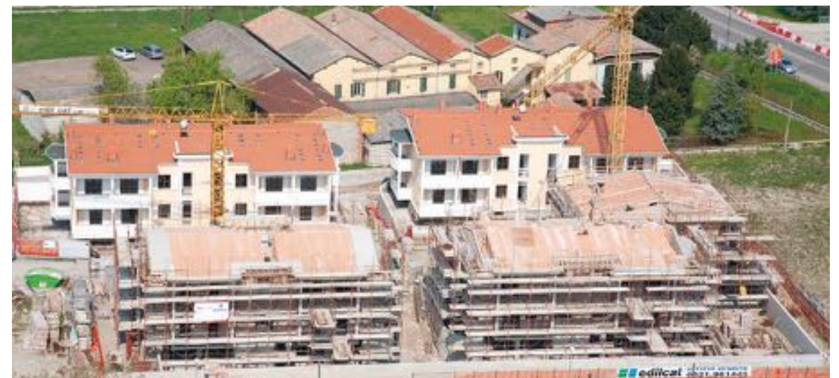
Intervento di 40 alloggi a PONTETARO NOCETO (PR) - 2008-2009
