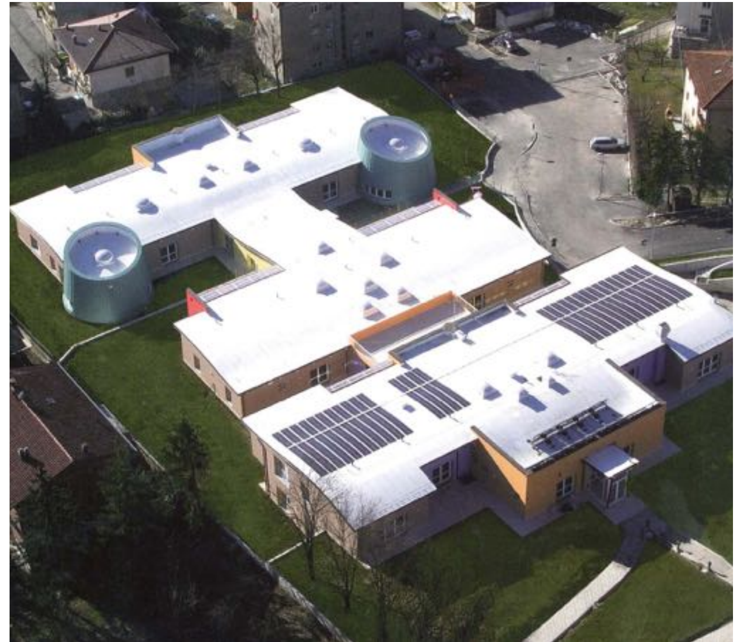
Edificio scolastico a PAVULLO (MO) - 2011
