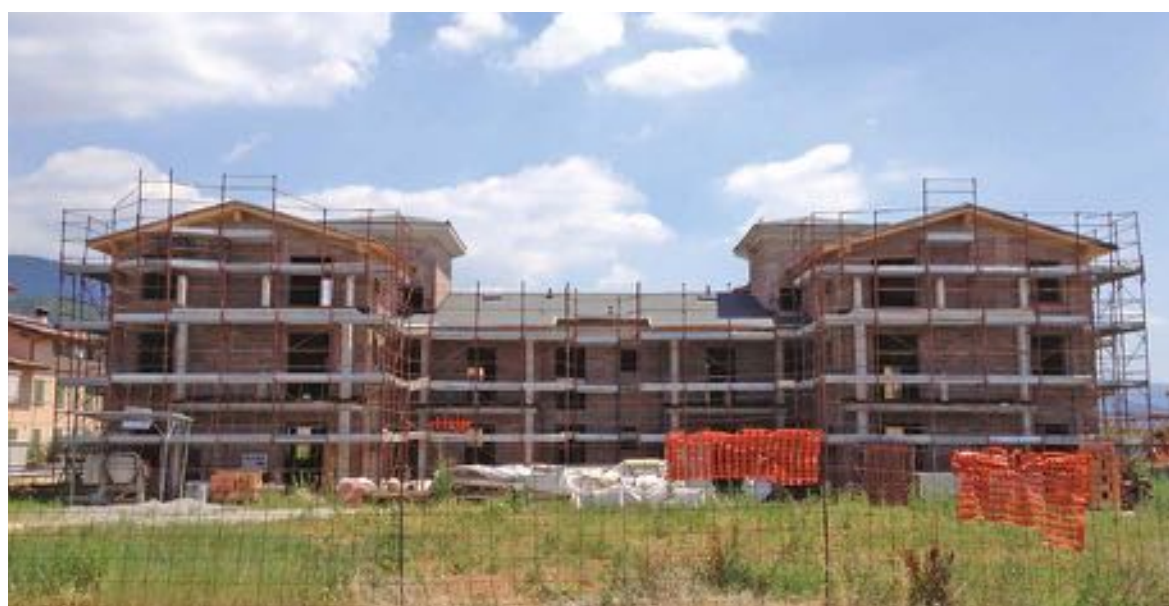
Intervento di 17 alloggi a RODENGO SAIANO (BS) - 2012
