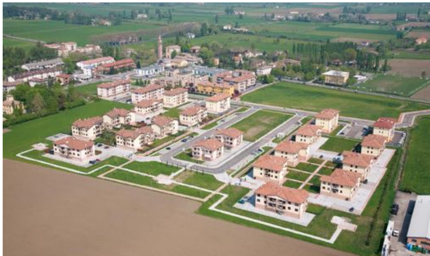
Realizzazione di 23 palazzine a SAN PROSPERO (PR) - 2007
