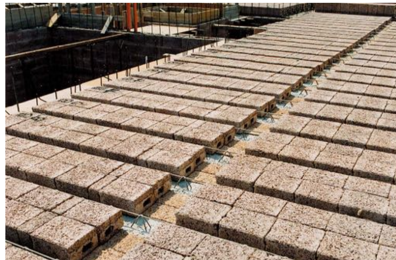
Esempio di coibentazione di una trave
