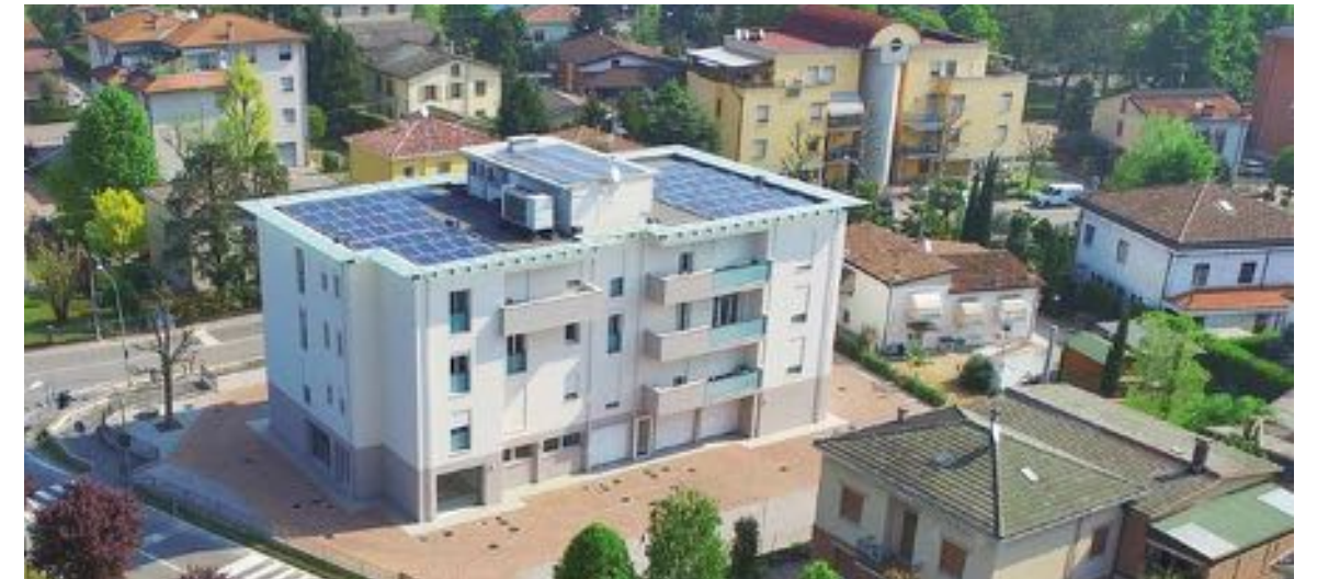
Edificio residenziale a CAVEZZO (MO) - 2016
