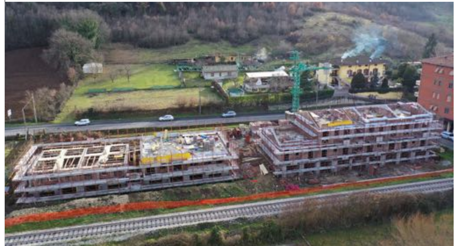
Intervento di 2 palazzine 16 alloggi a RIETI - 2020
