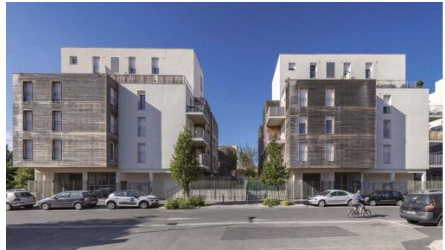
Quartiere residenziale realizzato ad AVIGNONE - (FRANCIA) - 2014-2015
