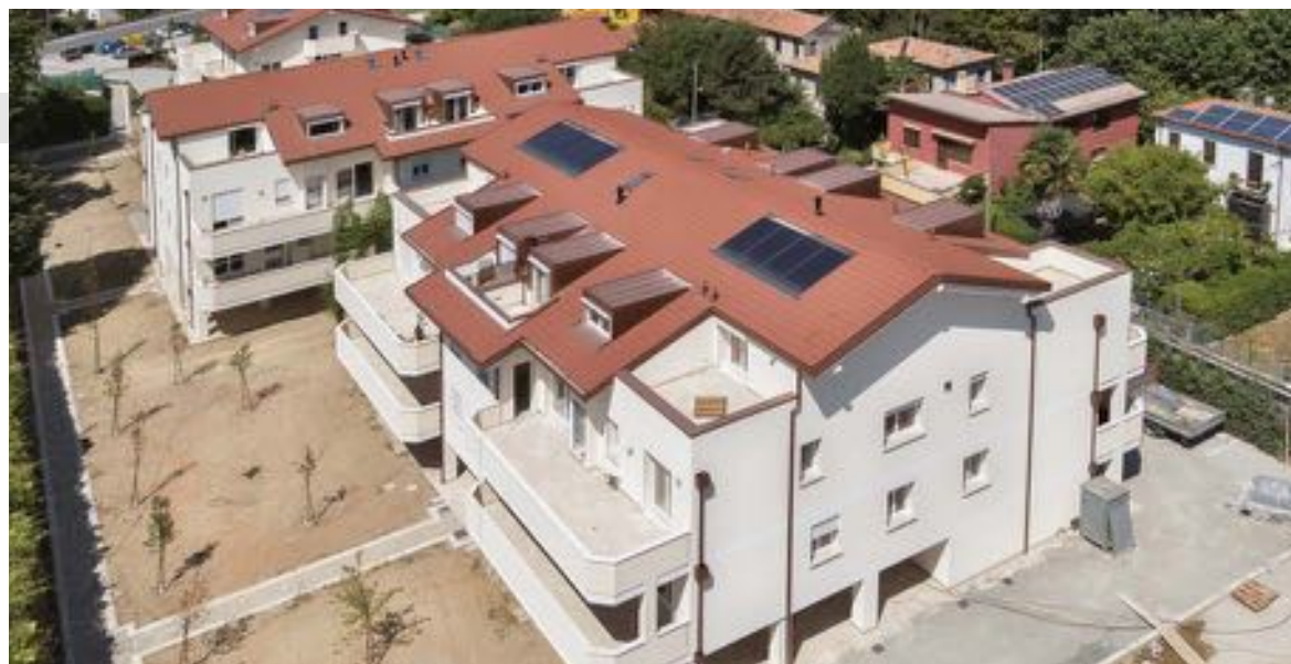
Intervento di 2 palazzine a PADOVA - 2011
