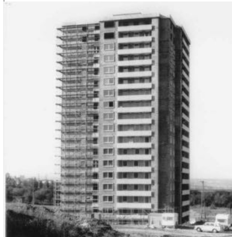
Edificio 17 piani a BAD WALDSEE - 1974
