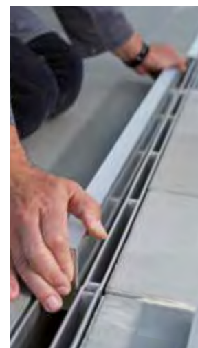
Esempio di montaggio della barra LED nella caditoia a fessura
