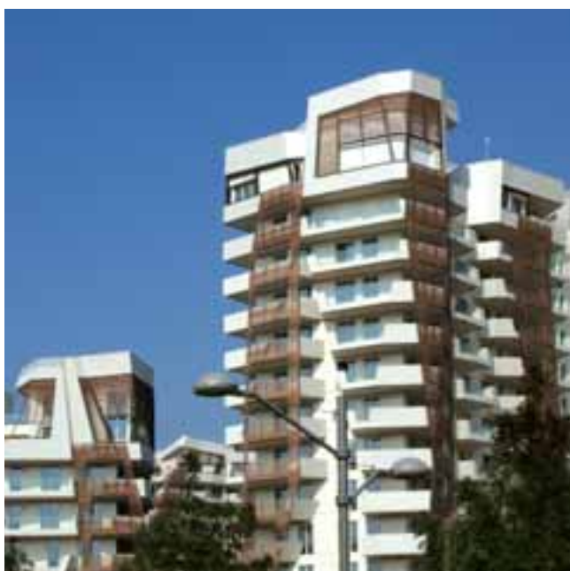
City Life Milano Complesso Zaha Hadid Calcestruzzo leggero strutturale.
