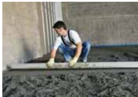
Massetto per pavimentazioni di coperture e terrazzi.
