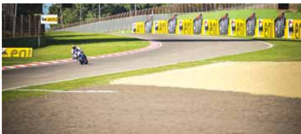
Curva Rivazza Autodromo Imola Sistema di protezione passiva delle vie di fuga.
