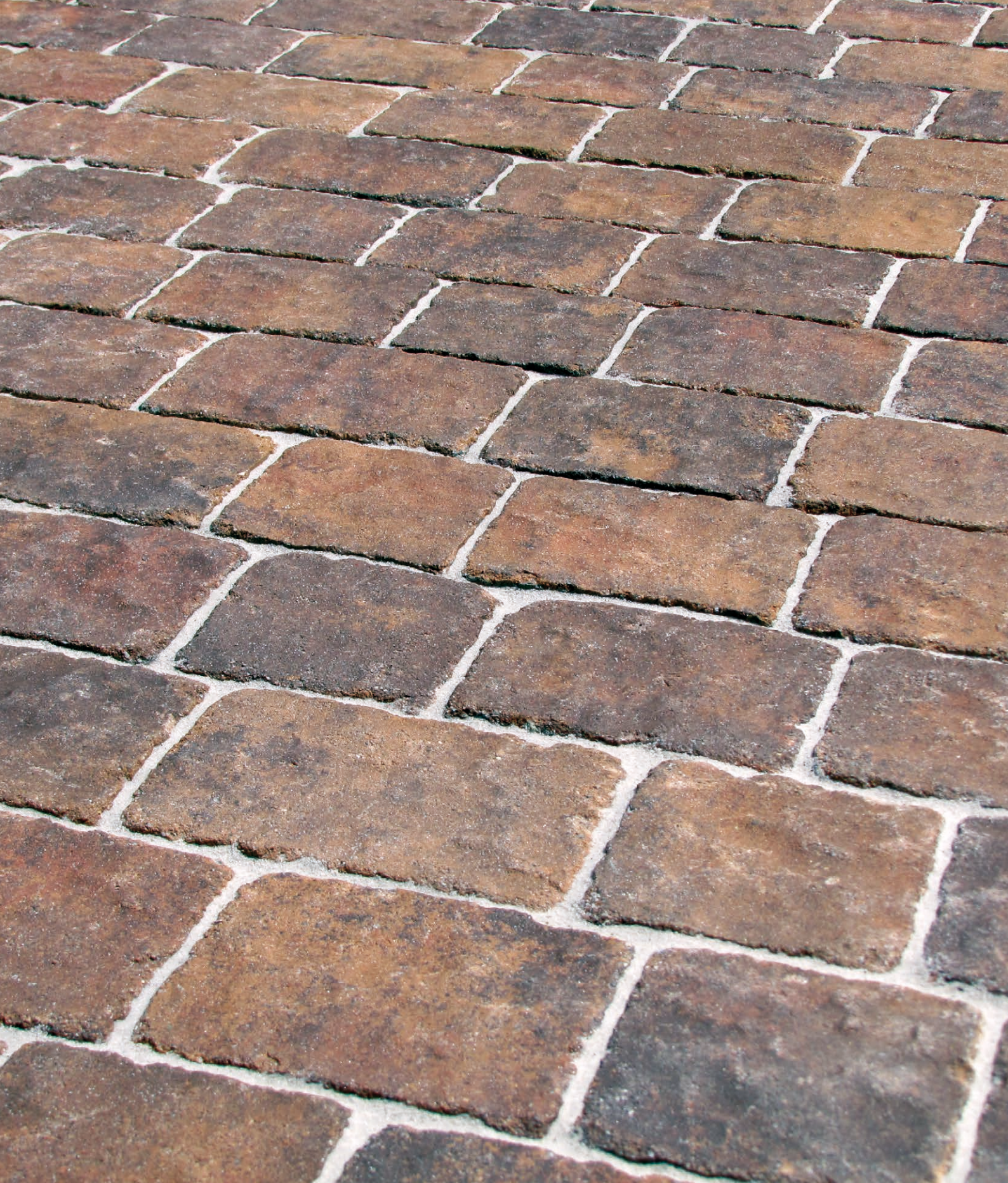
VIA SALARIA ANTICHIZZATO color PORFIDO - sigillatura del giunto con sabbia polimera
