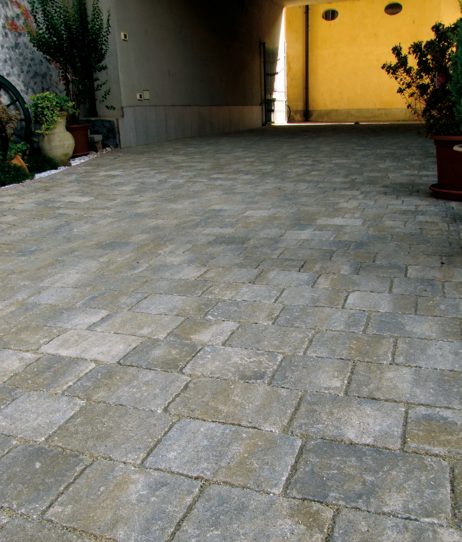
VIA SALARIA ANTICIZZATO color LUSERNA - sigillatura del giunto con sabbia polimera
