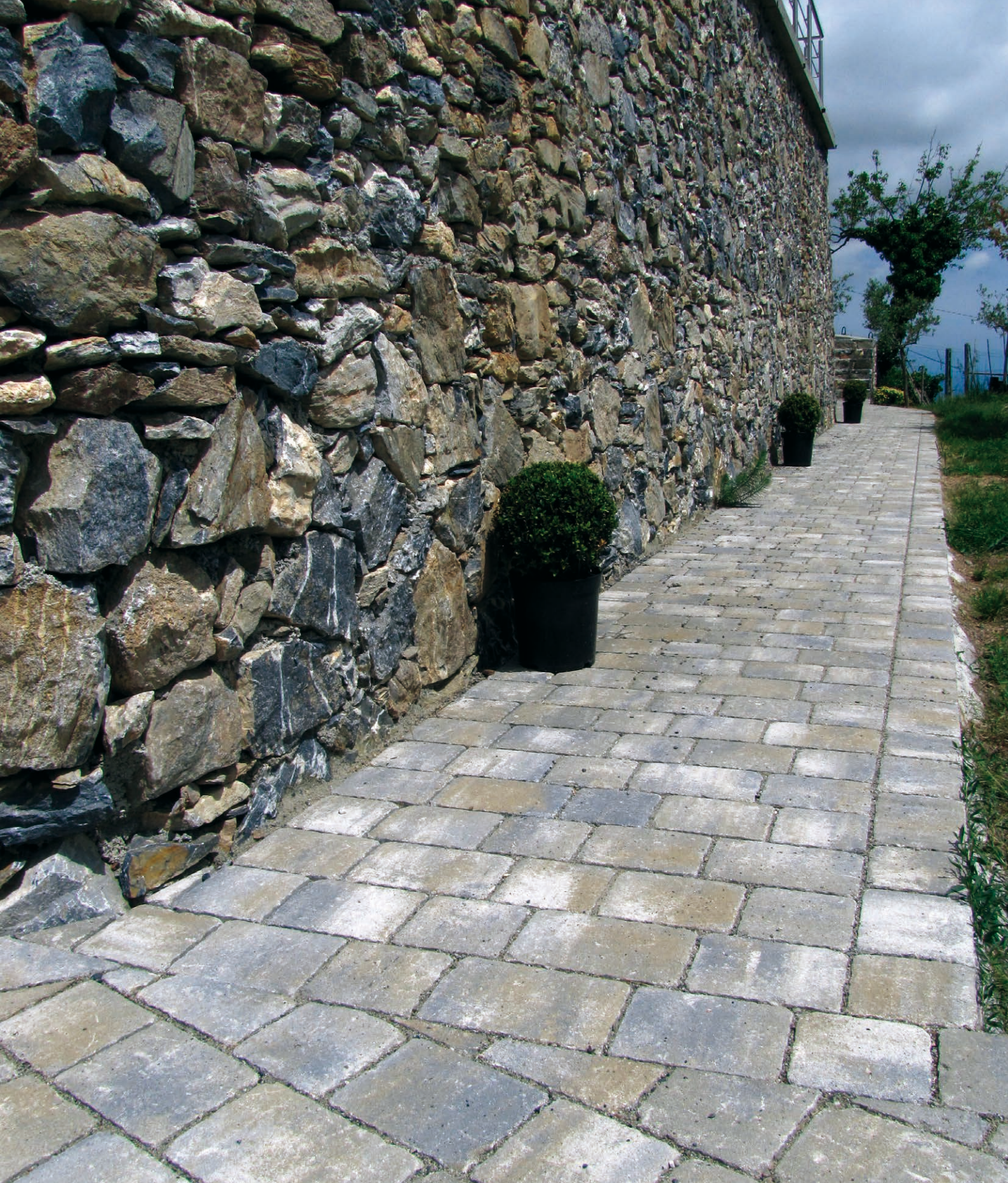
TREPEZZI ANTICHIZZATO color LUSERNA - sigillatura del giunto con sabbia polimera
