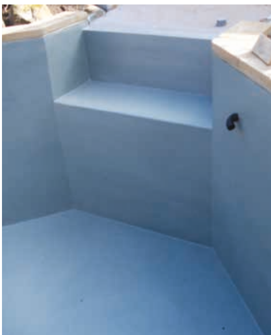
Per l'impermeabilizzazione di piscine e serbatoi di acqua potabile è obbligatorio l'uso di prodotti certificati.
