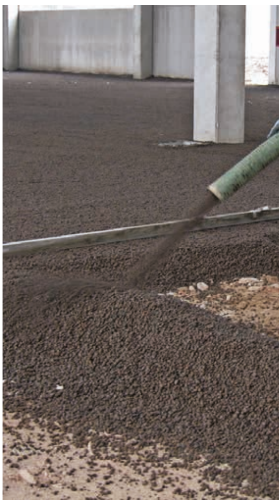
Il massetto alleggerito è meno coerente dei comuni massetti, poichè costituito da inerti leggeri o sostanze schiumogene
