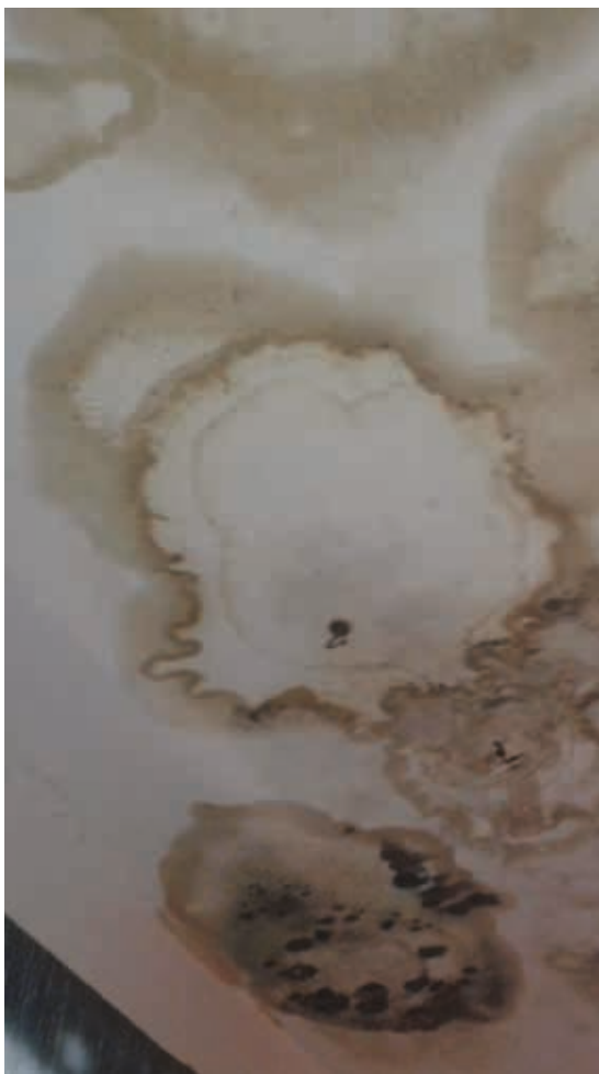
Una buona impermeabilizzazione permette di scongiurare eventuali infiltrazioni all'interno dell'edificio.
