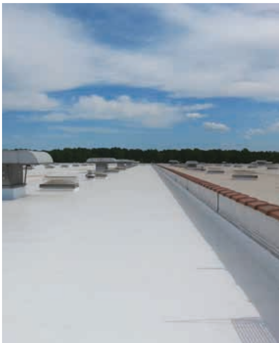
Le coperture piane consentono un limitato deflusso delle acque e richiedono quindi interventi d'impermeabilizzazione mirati
