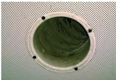
Fig. 2.7 Negli impianti centralizzati le tubazioni tendono ad accumulare polvere nel tempo, perciò hanno necessità di manutenzioni frequenti e accurate.
