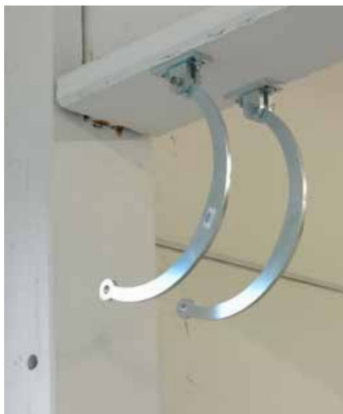
Fissaggio MEZZALUNE M1 su F3
