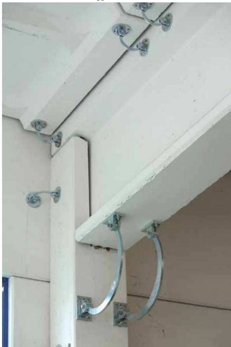
Fissaggio MEZZALUNE M1 su F3
