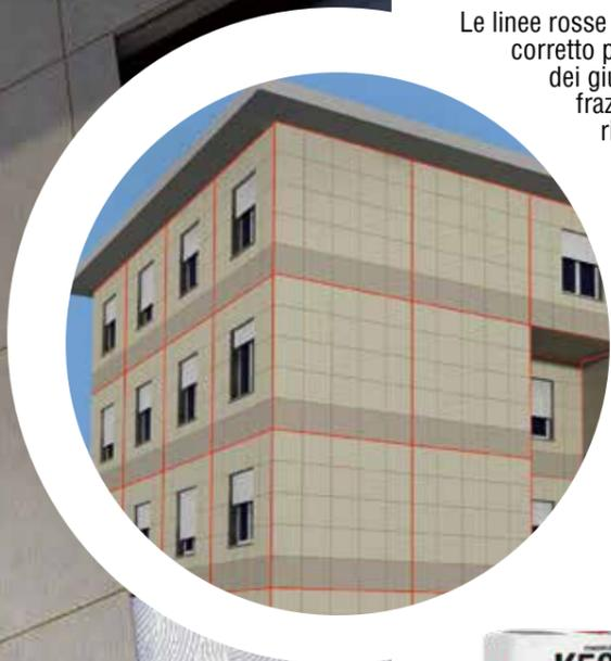
Le linee rosse indicano il corretto posizionamento dei giunti elastici di frazionamento nel rivestimento di facciata.
