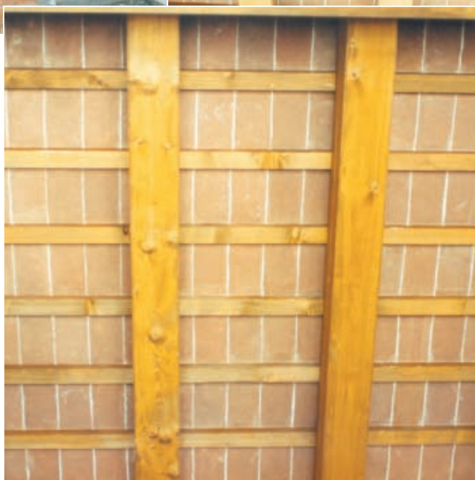
Sottotetto realizzato con Tavelle 15x30x3 cod. 282
