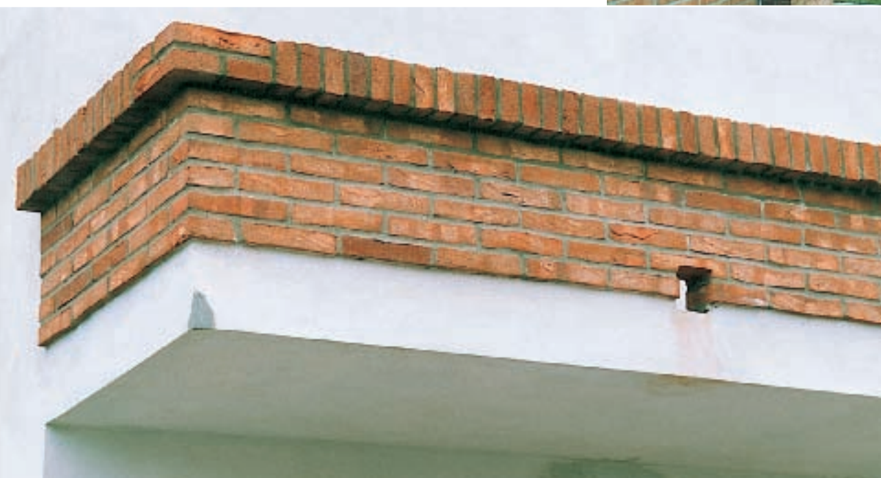
Vari particolari costruttivi con mattone Cod. 77 e coprimuretta Cod. 95
