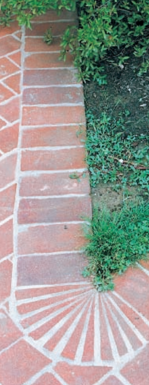
Vari particolari costruttivi con mattone Cod. 77 e coprimuretta Cod. 95
