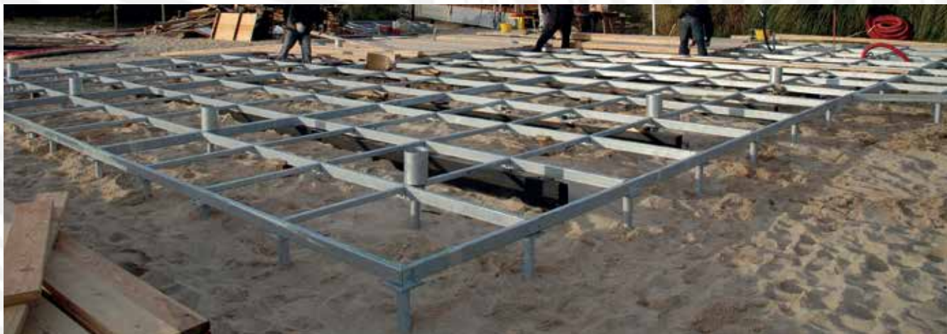
Es. FASE 1 - Montaggio impalcato metallico modulare Ex. STEP 1 - Mounting of metal and modular scaffolding
