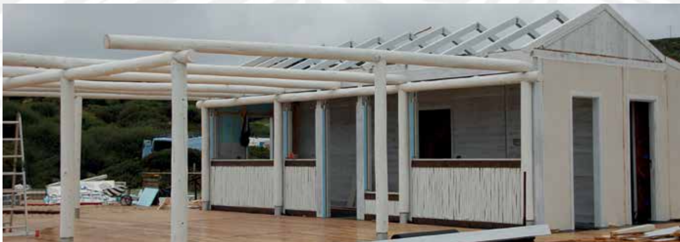
Es. FASE 2 - Montaggio pareti e realizzazione impiantistica idraulica ed elettrica Ex. STEP 2 - Walls mounting, plumbing and electrical system installation
