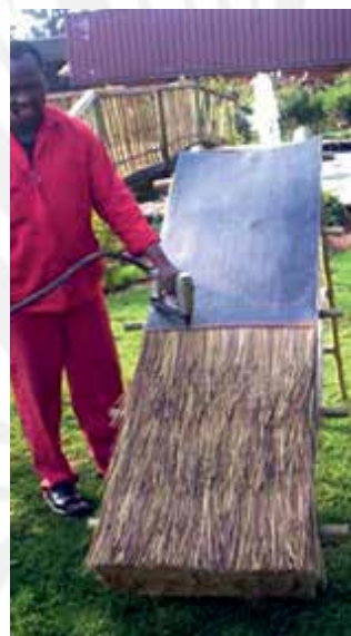
5 a fase: Fissaggio delle tegole in Polyolephin con semplici graffe, chiodi o viti; eventuale aggiunta del cornicione nella parte terminale per un effetto piu' corposo. 5th step: Polyolephin tiles can be fixed with staples, nails or screws. Eave section can be added to give a thick thatch look
