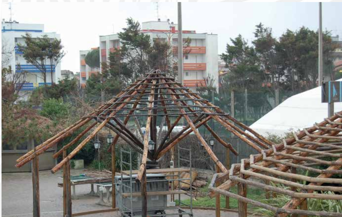
Fase 1. Realizzazione struttura primaria portante in eucalipto sudafricano / Step 1: South african eucalyptus main frame
