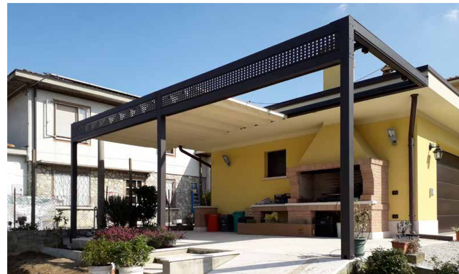
Realizzazione trave su richiesta del cliente
