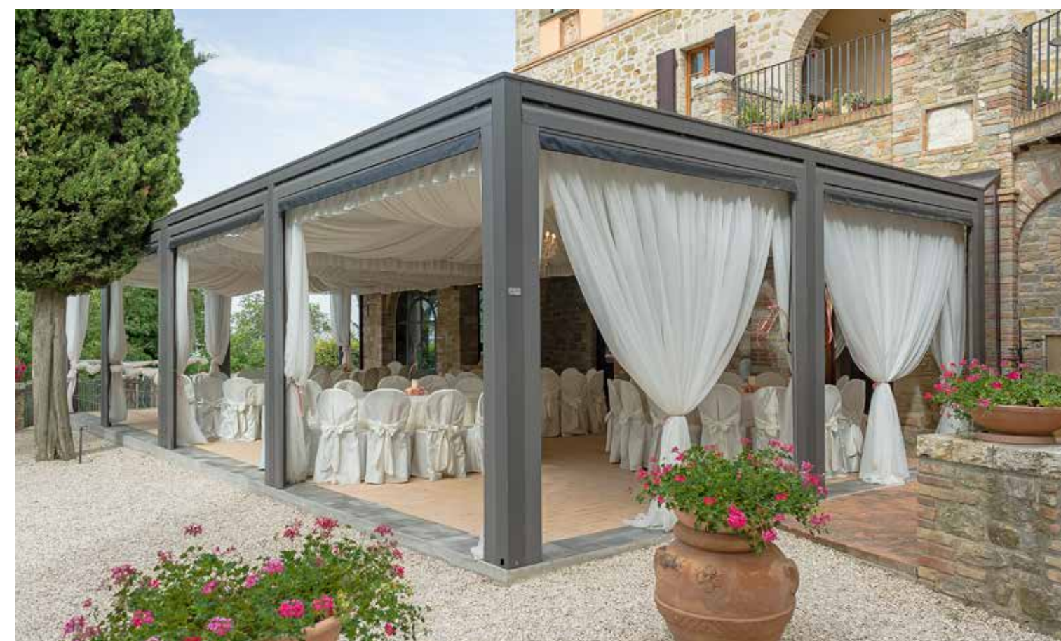
Predisposizione per tendaggi interni
