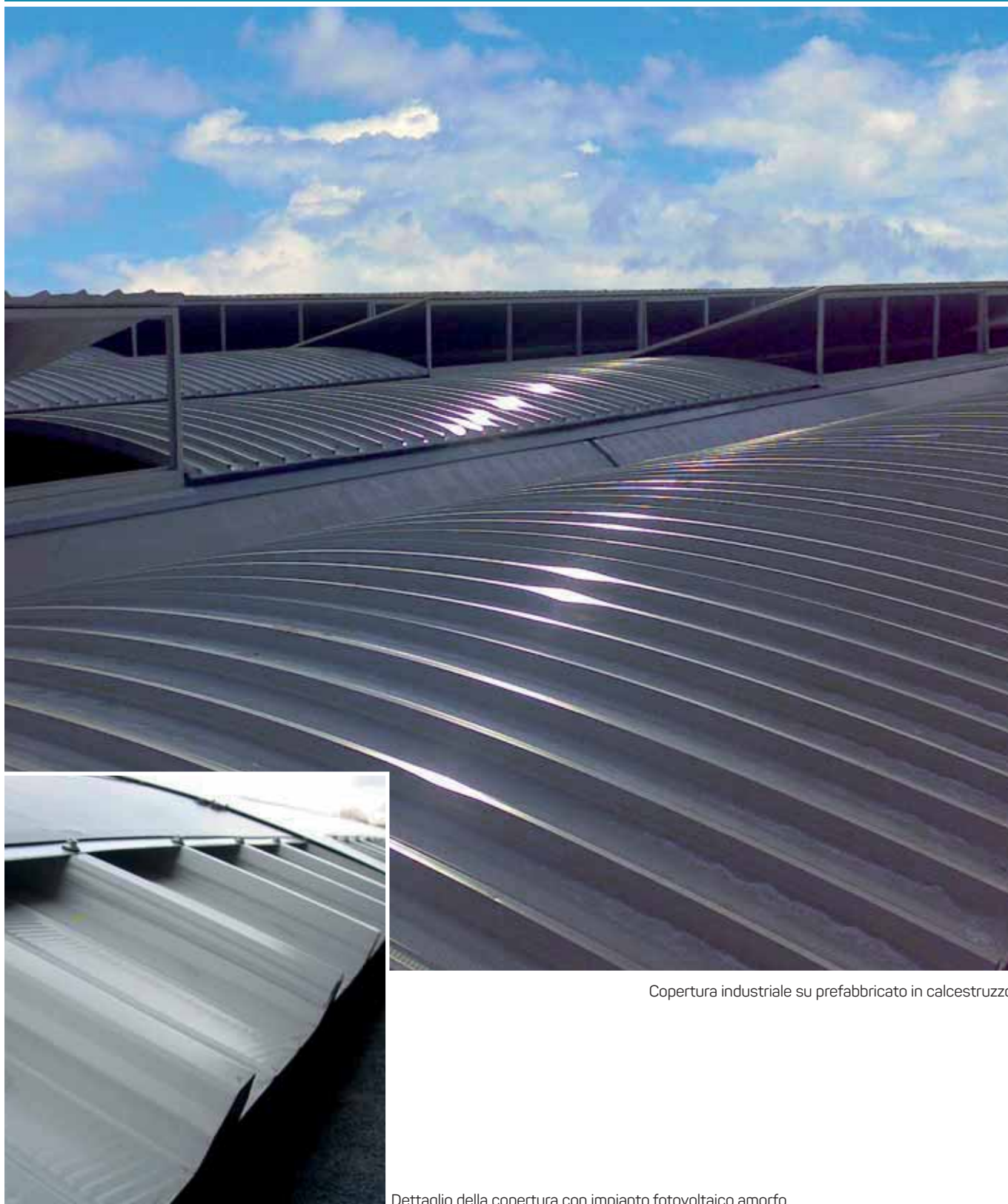
Dettaglio della copertura con impianto fotovoltaico amorfo
