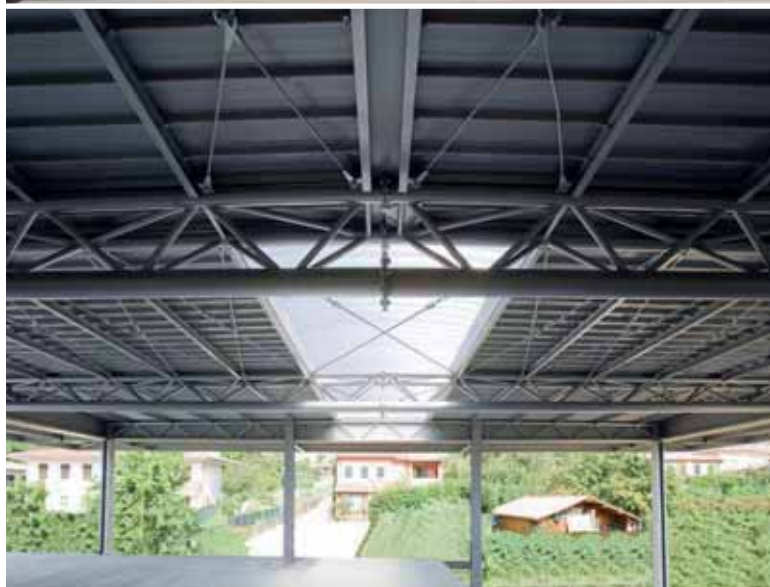
Dettaglio dell'intradosso della copertura
