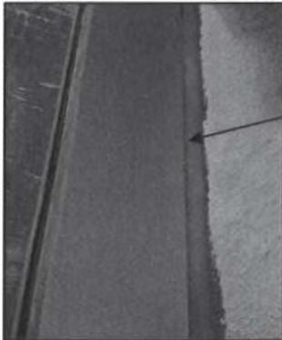
8- La finition est assurée par application d'un joint silicone neutre,
