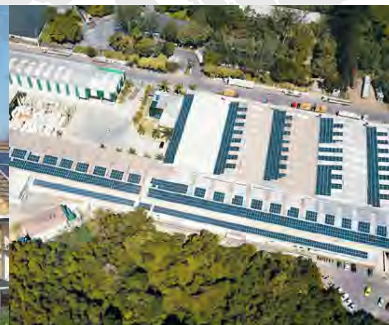
Serra Vitoria - Brasile Tetto industriale FU 265 P - 758 kWp
