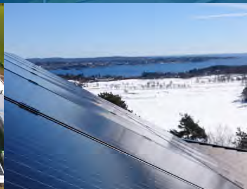
Larvik - Norvegia Impianto su tetto FU 290 M - 22 kWp
