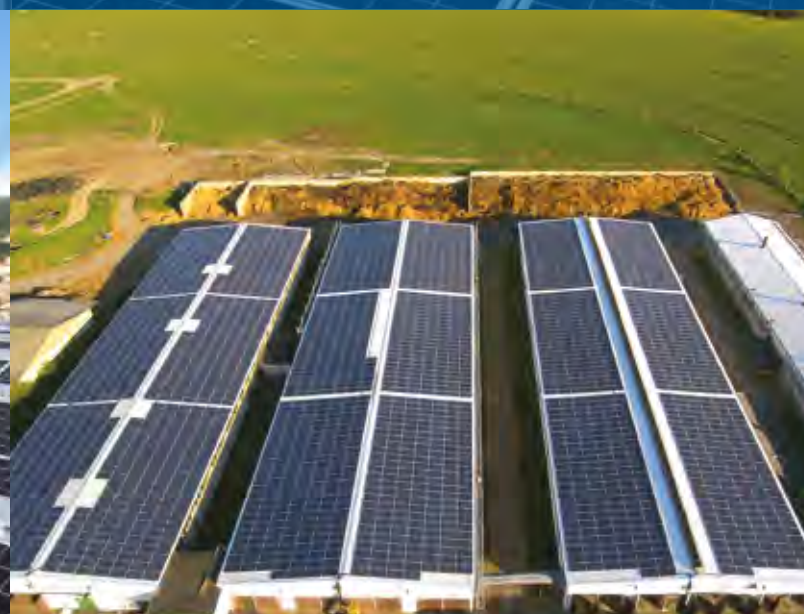
Zirzow - Neubrandenburg - Germania Fabbricato agricolo/stalla FU 260 P - 894 kWp
