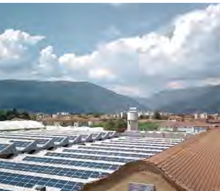
BAXI - Bassano del Grappa (VI) - Italia Tetto industriale FU 270 P - 992 kWp
