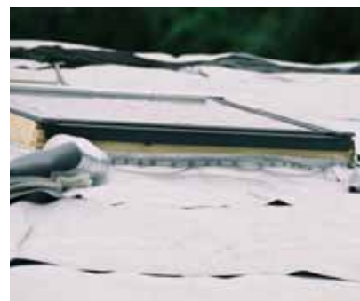
Fissare sul rialzo, con graffette e/o fissaggio con listello, risalendo sul telaio della finestra del tetto.
