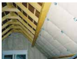
Avvitare i dischi di fissaggio passante per sostenere i profili per cartongesso, attraverso l'isolante. Posare la finitura in cartongesso.
