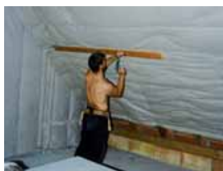
Per assicurare un fissaggio perfetto sui sormonti, fissare una perlina di legno inchiodata o avvitata sotto la trave. Aggraffare e ricoprire di nastro adesivo sigillante.
