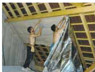
Tagliare i bordi al suolo. Aggraffare sotto travi, tra arcarecci. Graffe di 14 mm minimo.
