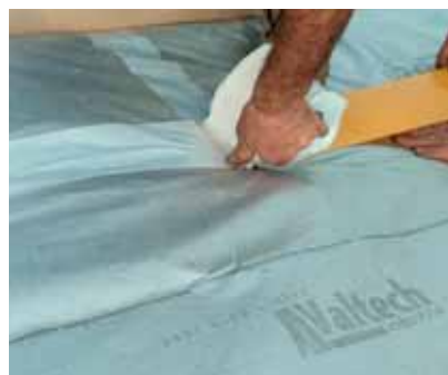
Posare del nastro adesivo sigillante per garantire l'impermeabilità.
