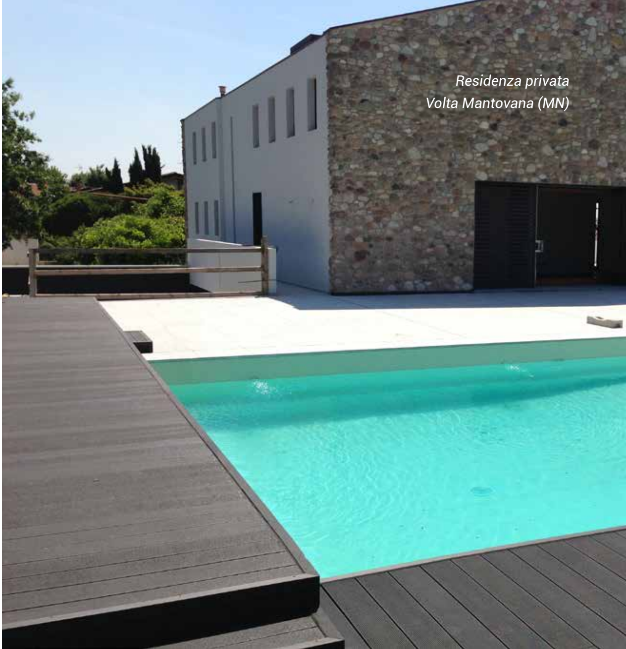
Pavimentazioni esterne Outdoor decking
