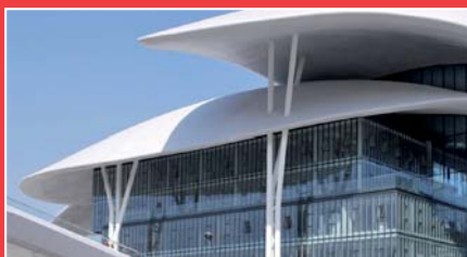
Tbilisi Public Service Hall Impermeabilizzazione copertura
