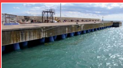
porto commerciale di Manfredonia Impermeabilizzazione e protezione di nr.1.500 pilastri in immersione.
