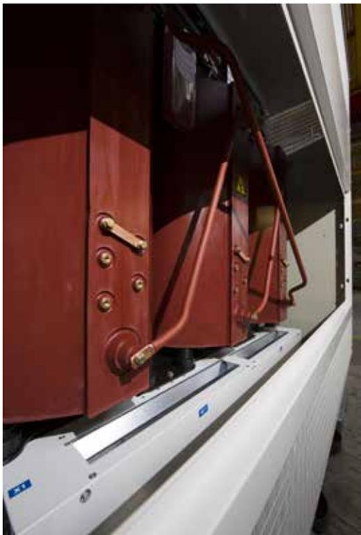
Трансформатор с принудительной вентиляцией в кожухе (класс защиты IP 31)
