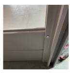
Таким же образом, в угловой столбик вставьте боковую стенку, одну или две, в зависимости от модели по направляющим и закрепить с помощью саморезов.
