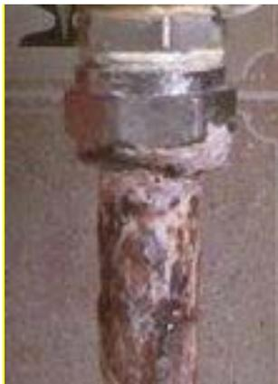
Накидная гайка накручена с применением льна. Это приводит к тому, что гайка не может обеспечить смыкание обжимного кольца (сухаря). Использование уплотнительного материала в данном случае недопустимо и не нужно, т.к. транспортируемая жидкость под гайку не поступает.
