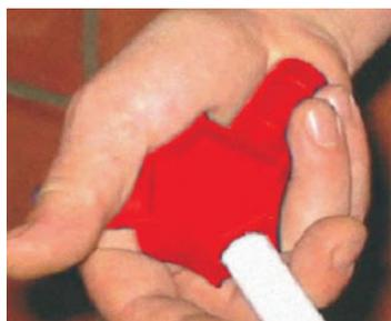
Для того, чтобы металлополимерная труба оделась на штуцер фитинга без значительных усилий, и не нарушила положения эластичных уплотнительных колец штуцера, конец трубы необходимо откалибровать внутренним калибратором.
